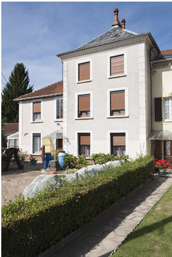
Façade antérieure, partie ouest.
