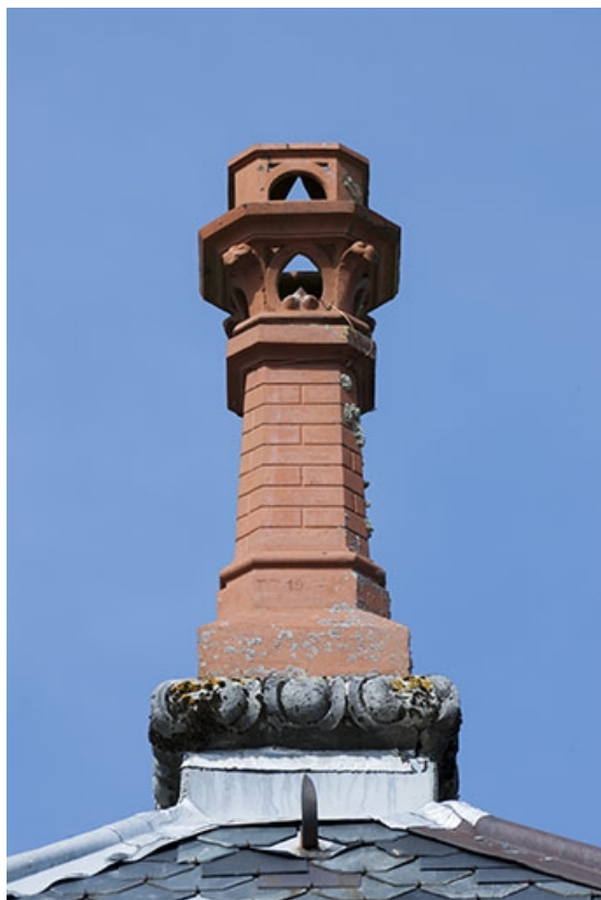
Détail : épi de faitage.
