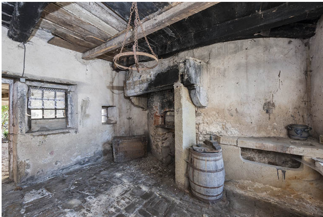
Rez-de-chaussée du pigeonnier circulaire.
