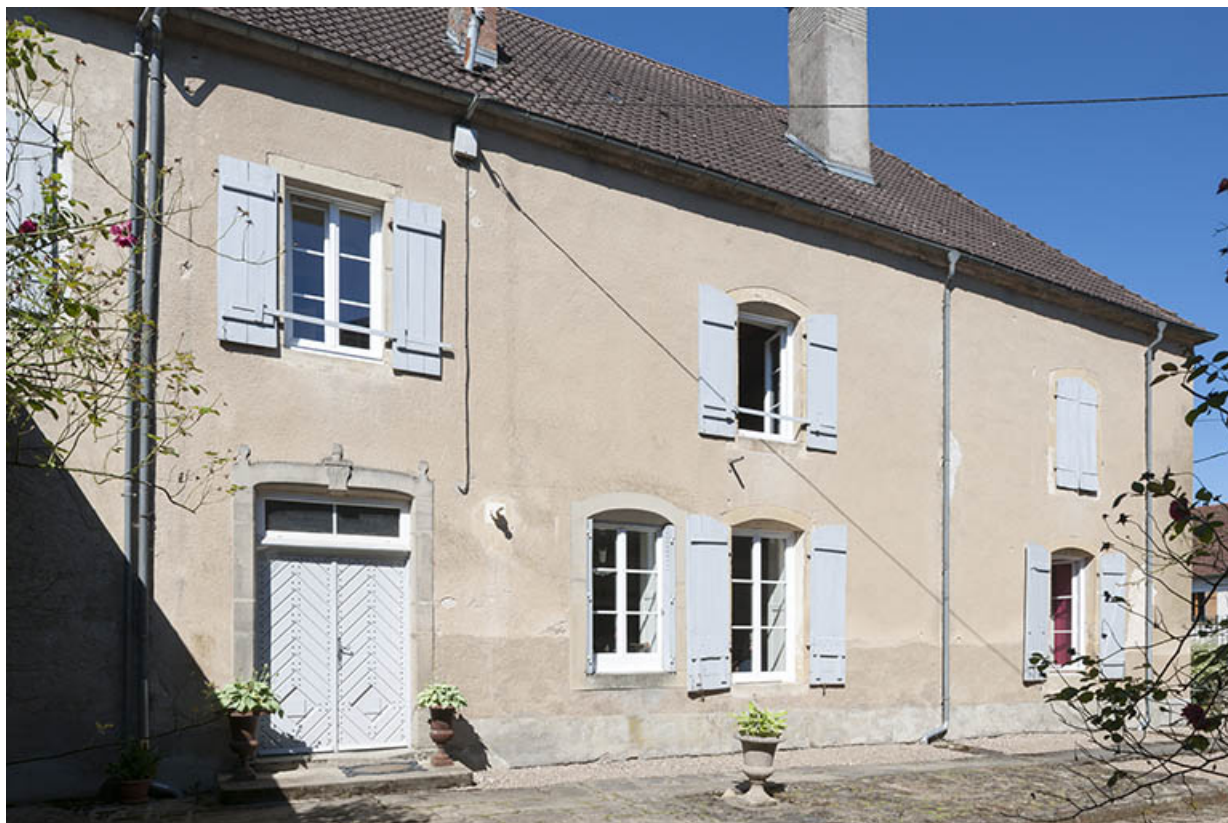
Vue générale, façade est.
