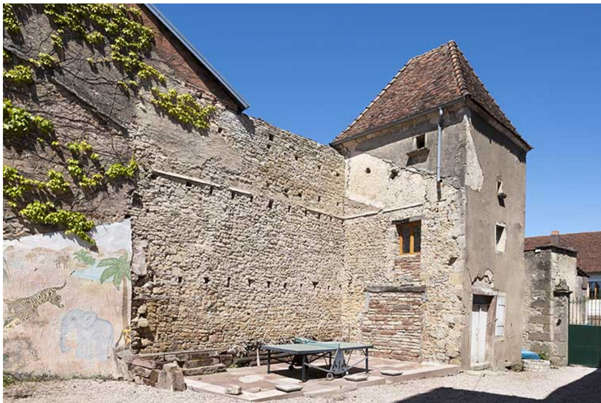
Vue sur l'emplacement de la grange abbatue et sur le pigeonnier de la partie ouest.
