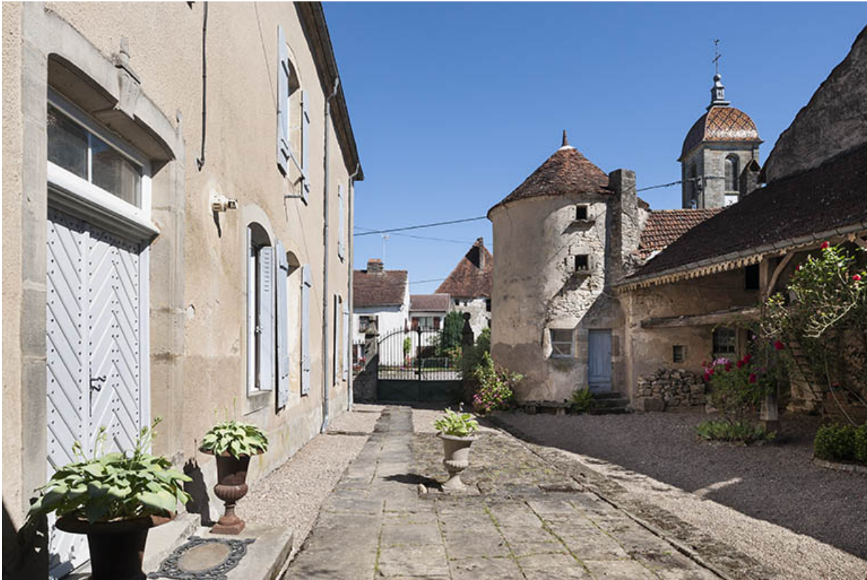
La cour, façade est.
