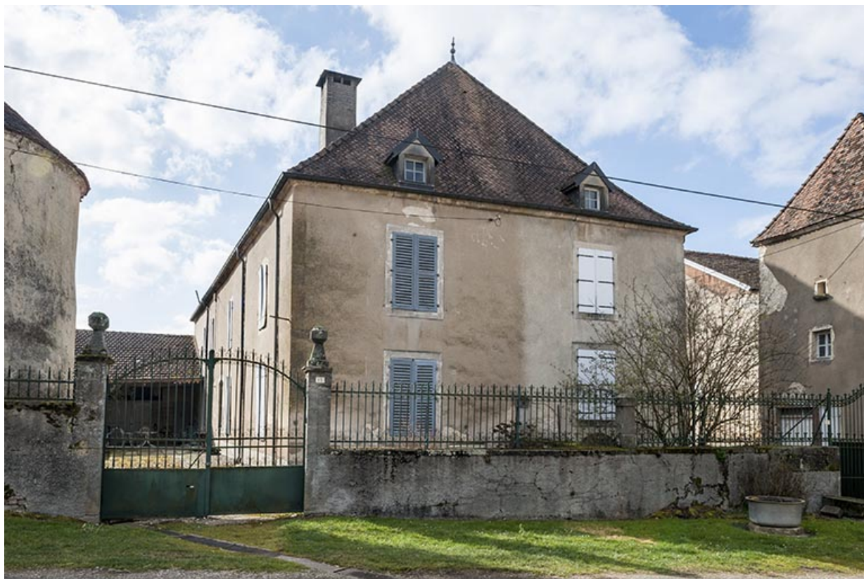
La demeure, façade nord.
