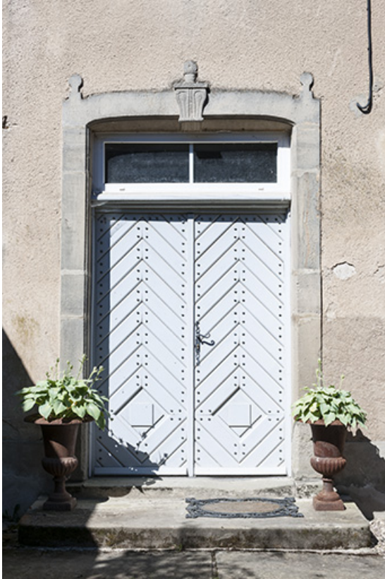
La porte d'entrée, façade est.
