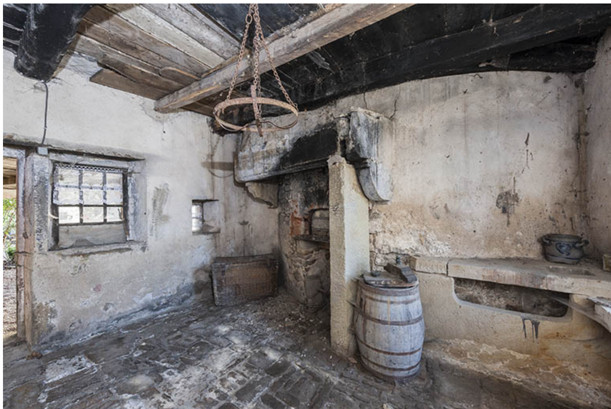
Rez-de-chaussée du pigeonnier circulaire.
