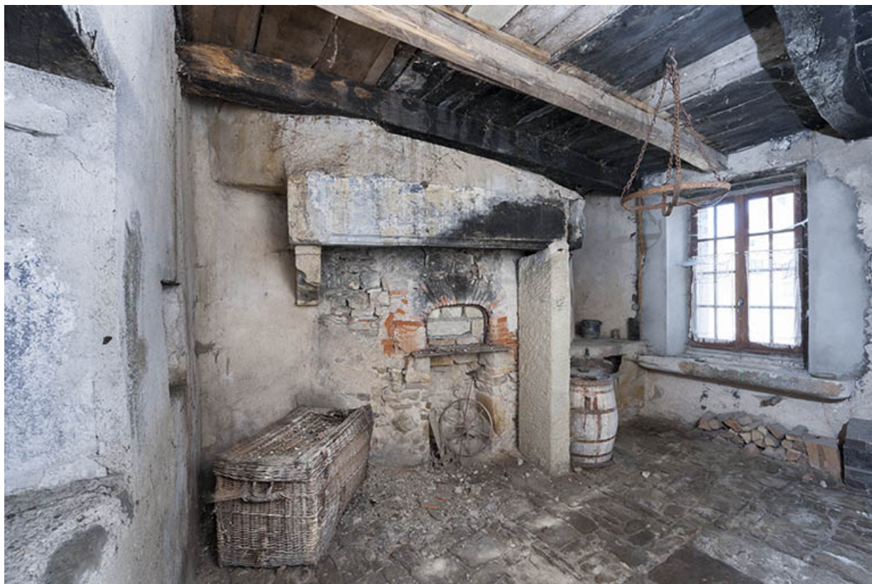
La cheminée et l'ouverture murée de l'ancien four à pain.
