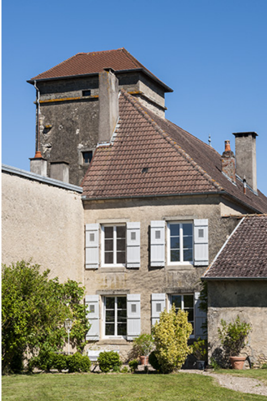
Façade postérieure de la partie est avec la tour en arrière plan. 70, Ormoy, 15 rue Antoine Lumière
