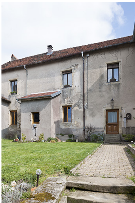
La façade antérieure.
