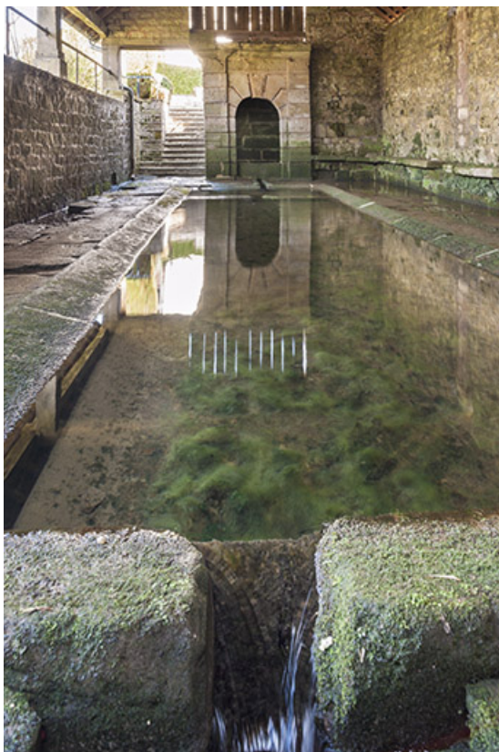
Le bassin et son déversoir.
