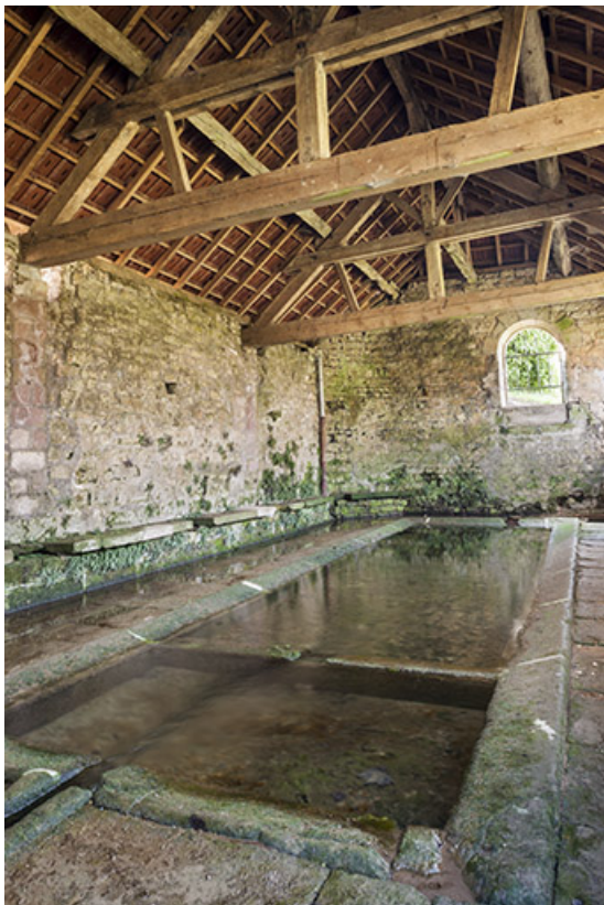
Vue générale des bassins.
