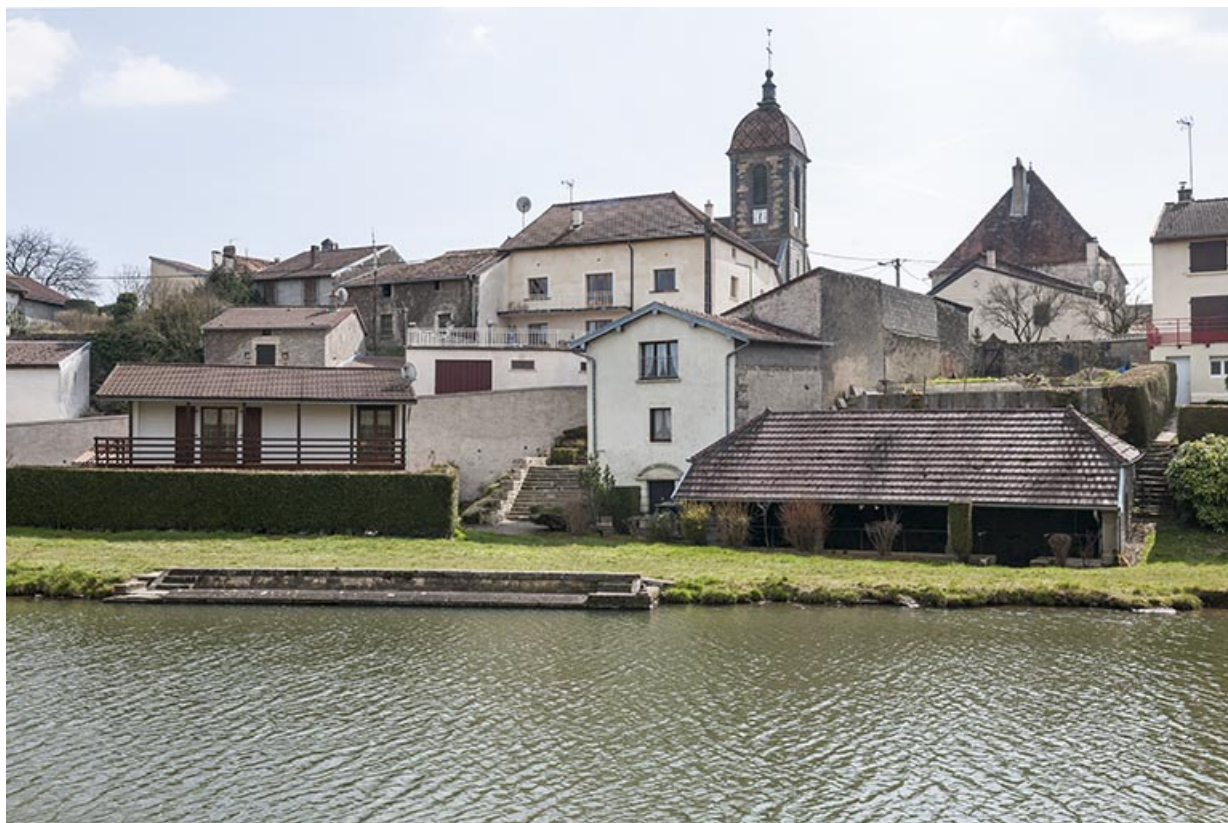
Le lavoir situé le long du canal.
