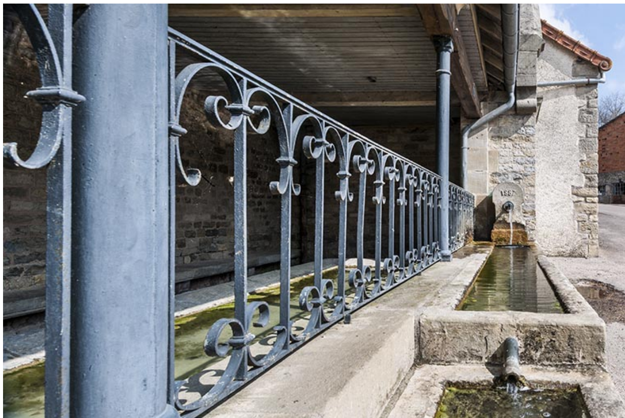
Le garde-corps et les abreuvoirs.
