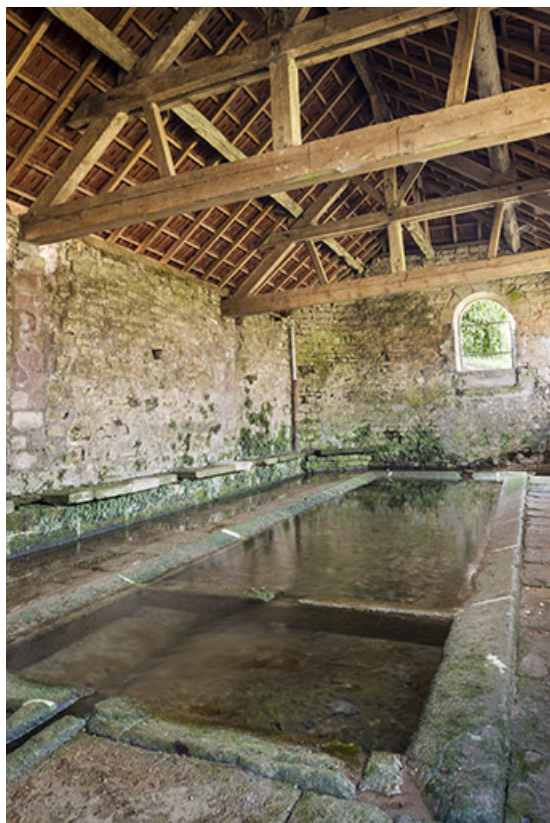
Vue générale des bassins.
