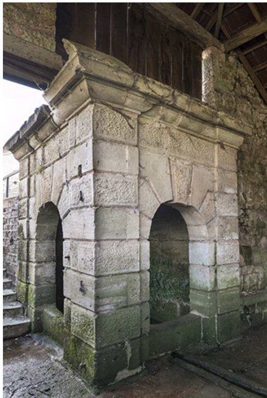
La fontaine alimentant le lavoir.
