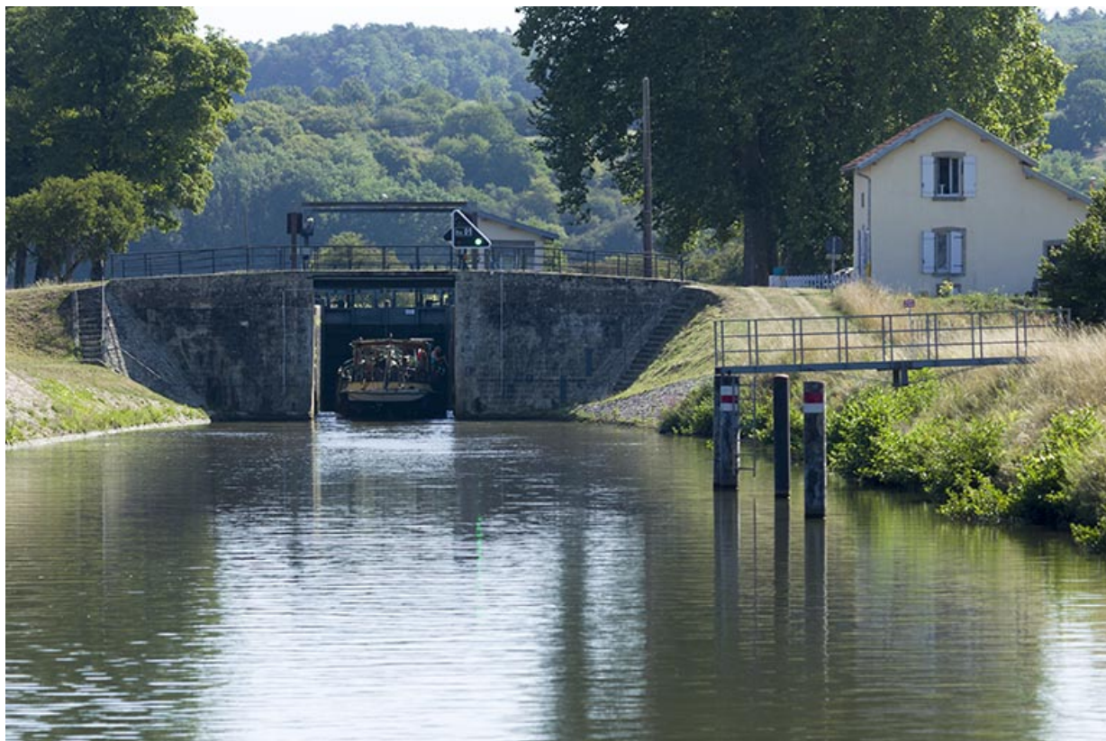
Site d'écluse, Ormoy.
