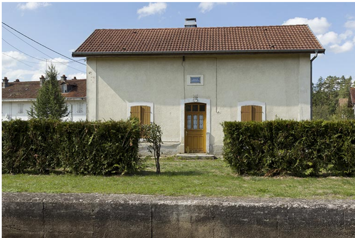
Vue de face de la maison d'éclusier.
