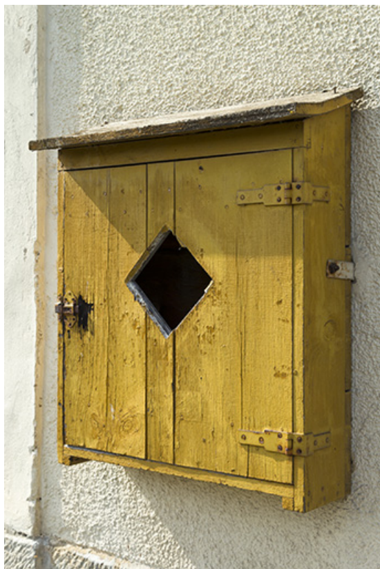
Détail d'une boîte à bouée sur la façade antérieure. 70, Demangevelle
