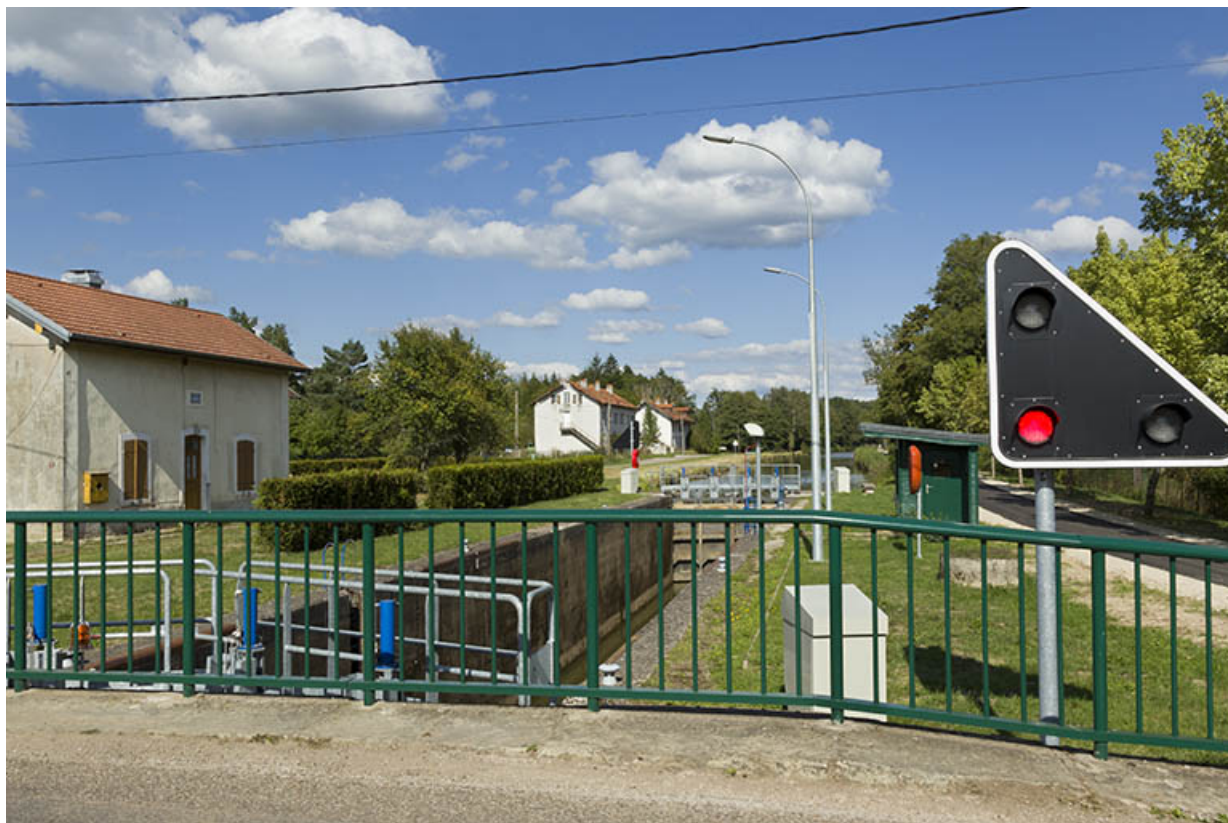
Vue de l'écluse vers l'amont depuis le pont. 70, Demangevelle
