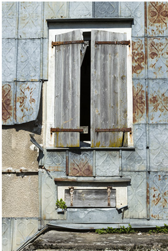
Détail de deux baies et de l'essentage de la façade sud-ouest. 70, Demangevelle
