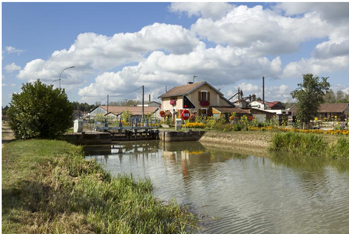
Vue d'ensemble du site d'écluse depuis la rive gauche en amont.
