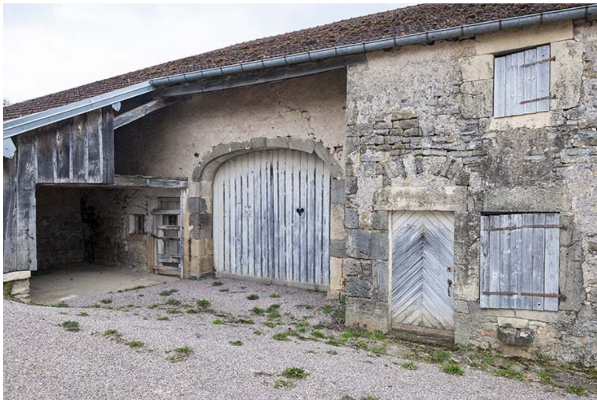
La façade principale, à trois travées.
