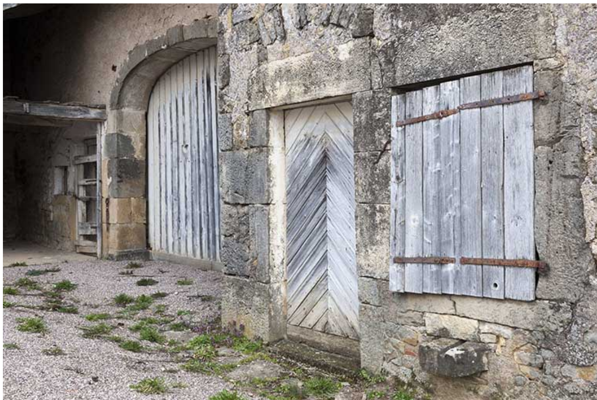
Détail sur la travée desservant la partie habitation.
