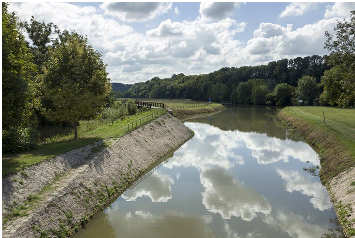
Vue aval depuis l'écluse n°46 du canal des Vosges et la Saône en arrière-plan. 70, Ormoy
