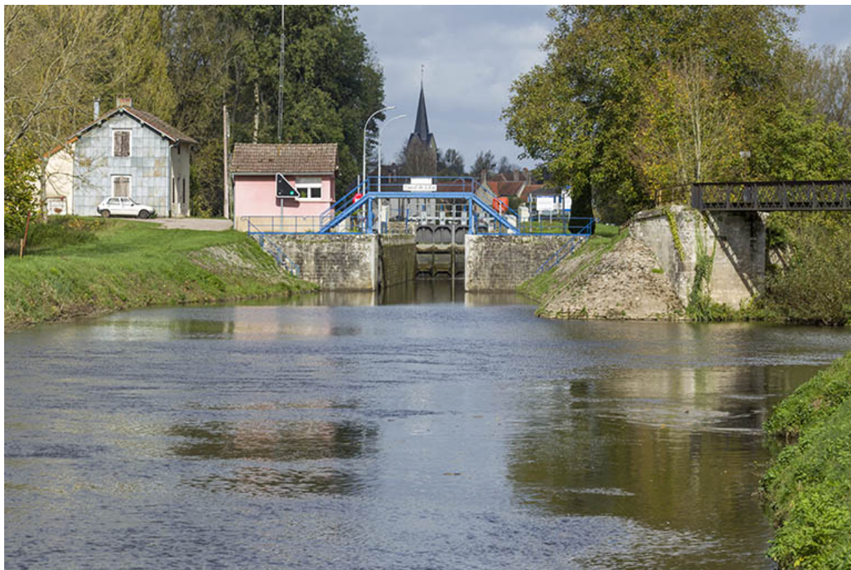
Depuis l'aval du site d'écluse n°46, la confluence du canal et du Coney, le poste de commande et la maison d'éclusier; Corre (70).
