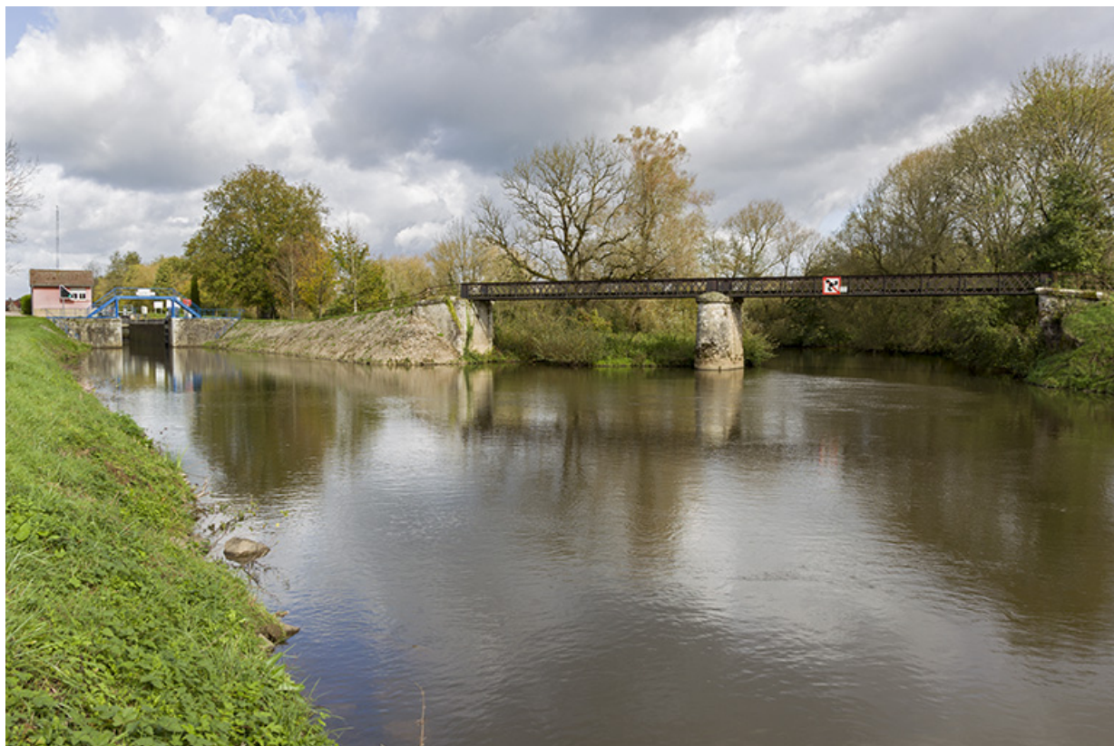
En amont de la confluence avec la Saône, la confluence du Coney et du canal, site d'écluse et passerelle sur le Coney, depuis le sud.
