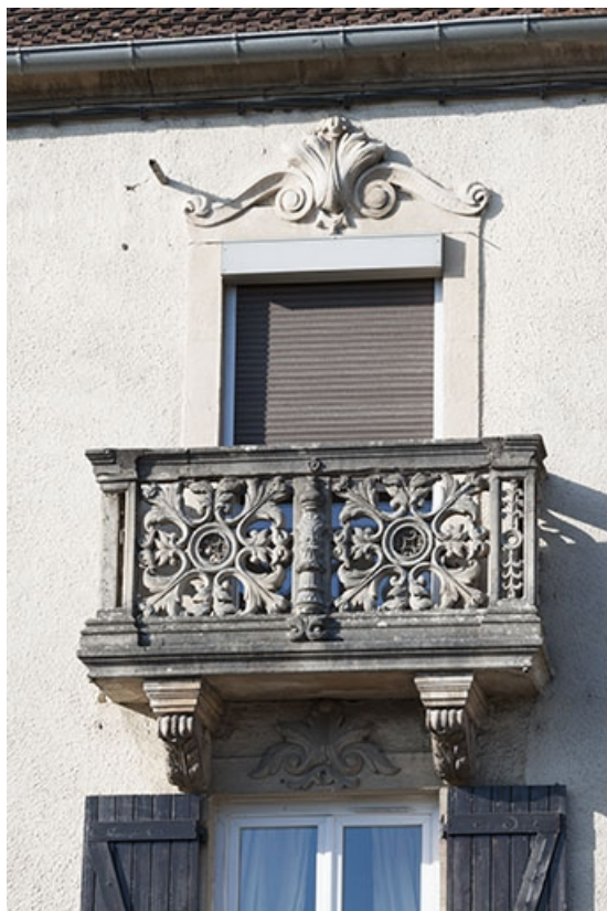
Façade antérieure : le balcon en pierre, vu de face.
