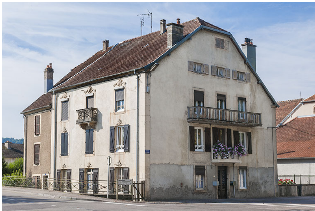
Vue générale à l'angle de la rue du Général Détrie et de l'avenue de la Gare. 70, Favorney, 1 avenue de la Gare
