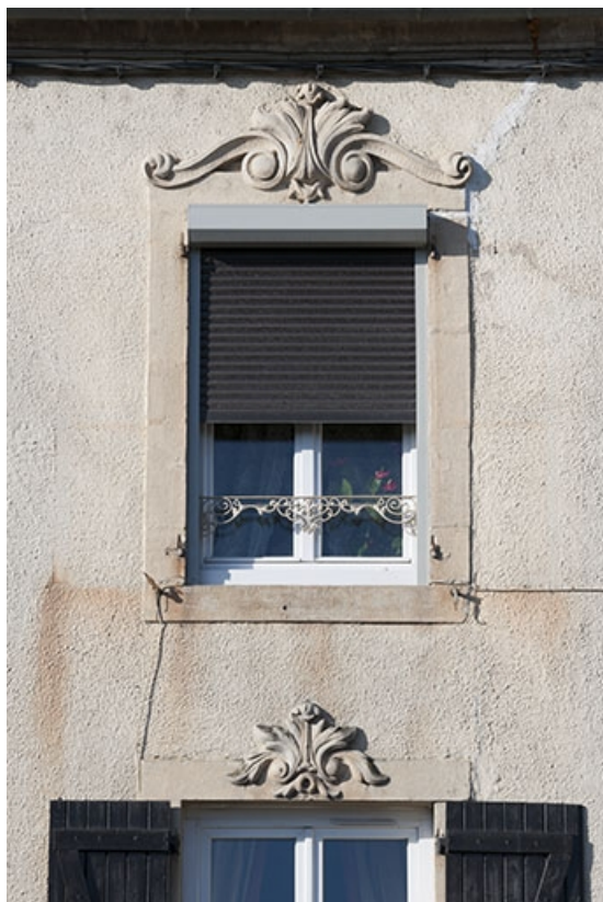
Façade antérieure : détail, décor des baies.
