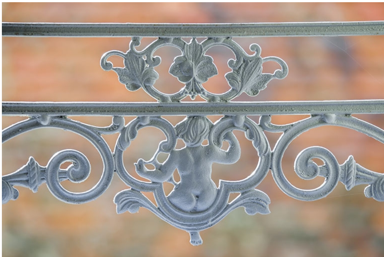
Barre d'appui d'une des baies, détail : le revers du motif central.
