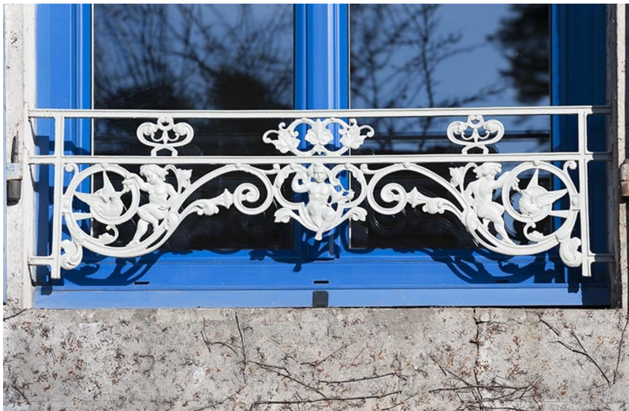
Vue d'ensemble de la barre d'appui, côté rue.
