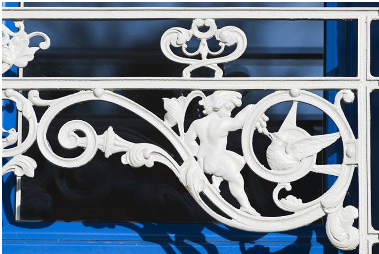
Barre d'appui d'une des baies, détail : le motif de droite.
