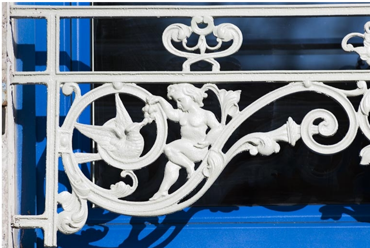
Barre d'appui d'une des baies, détail : le motif de gauche.
