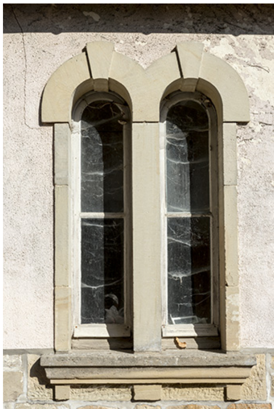
Détail des baies jumelées de l'ancienne dépendance.
