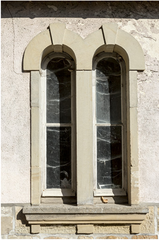
Détail des baies jumelées de l'ancienne dépendance.
