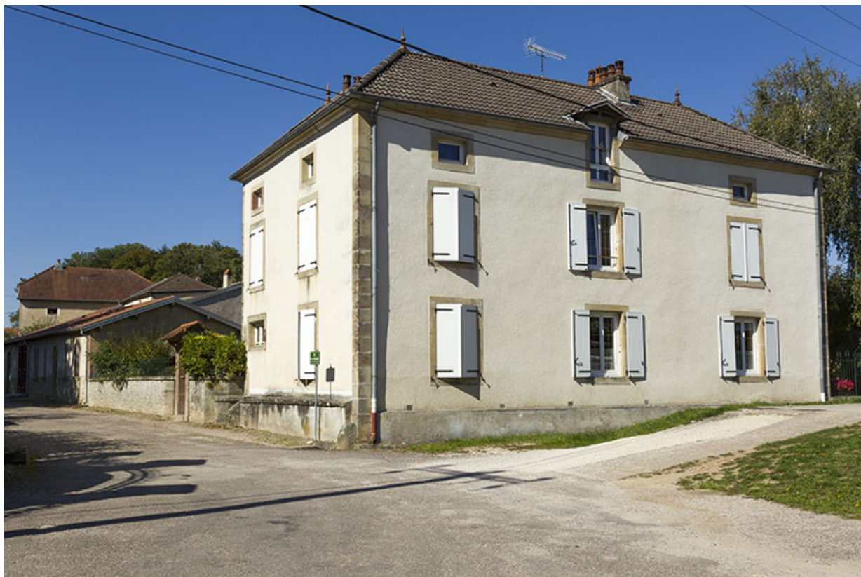
Vue de trois-quart sud-est de la façade donnant sur le canal.
