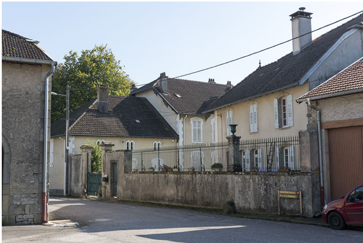
Vue depuis le nord-ouest sur l'entrée de la demeure, sa dépendance et sa façade (nord) sur rue. 70, Corre, 26, lieudit : 28 rue Billecard
