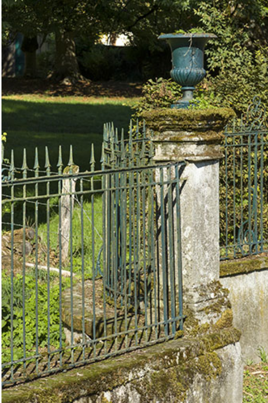
Détail de la clôture orientale.
