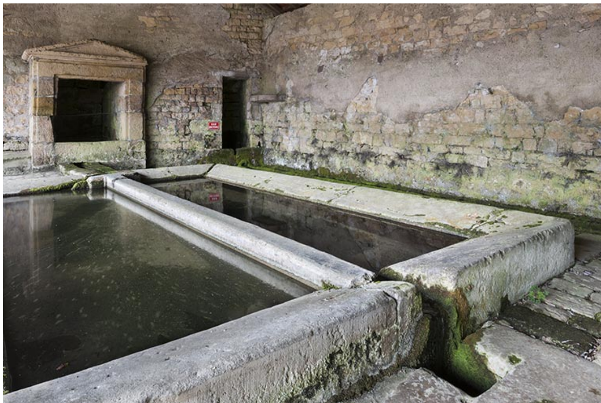
Détail des bassins.
