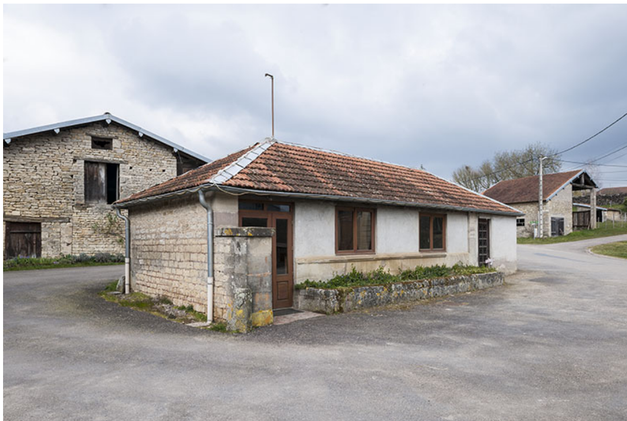
Le lavoir transformé en remise.
