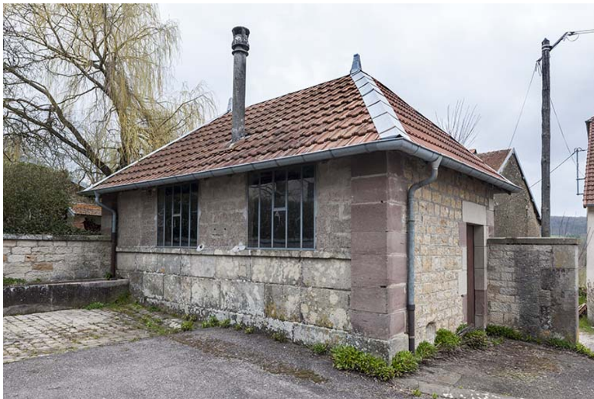
Le lavoir, transformé en local municipal. 70, Fouchécourt
