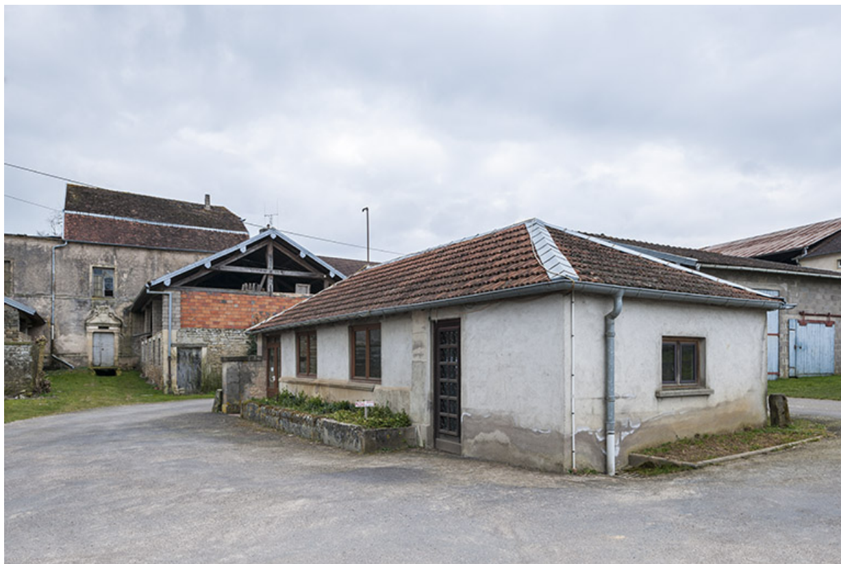
Lavoir dit "du bas". 70, Fouchécourt
