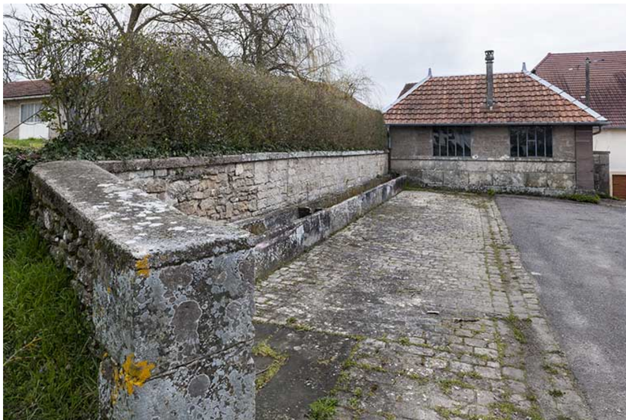
Lavoir dit " du haut". 70, Fouchécourt
