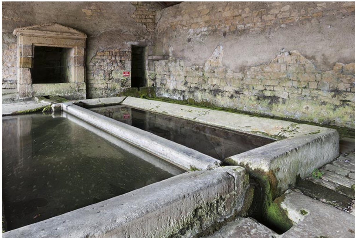
Détail des bassins.
