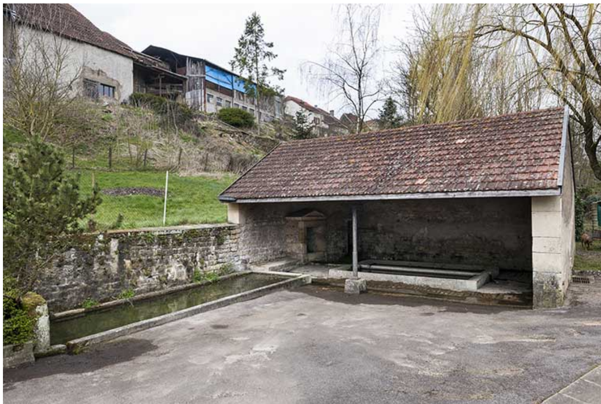
Lavoir, rue de la Fontaine. 70, Fouchécourt
