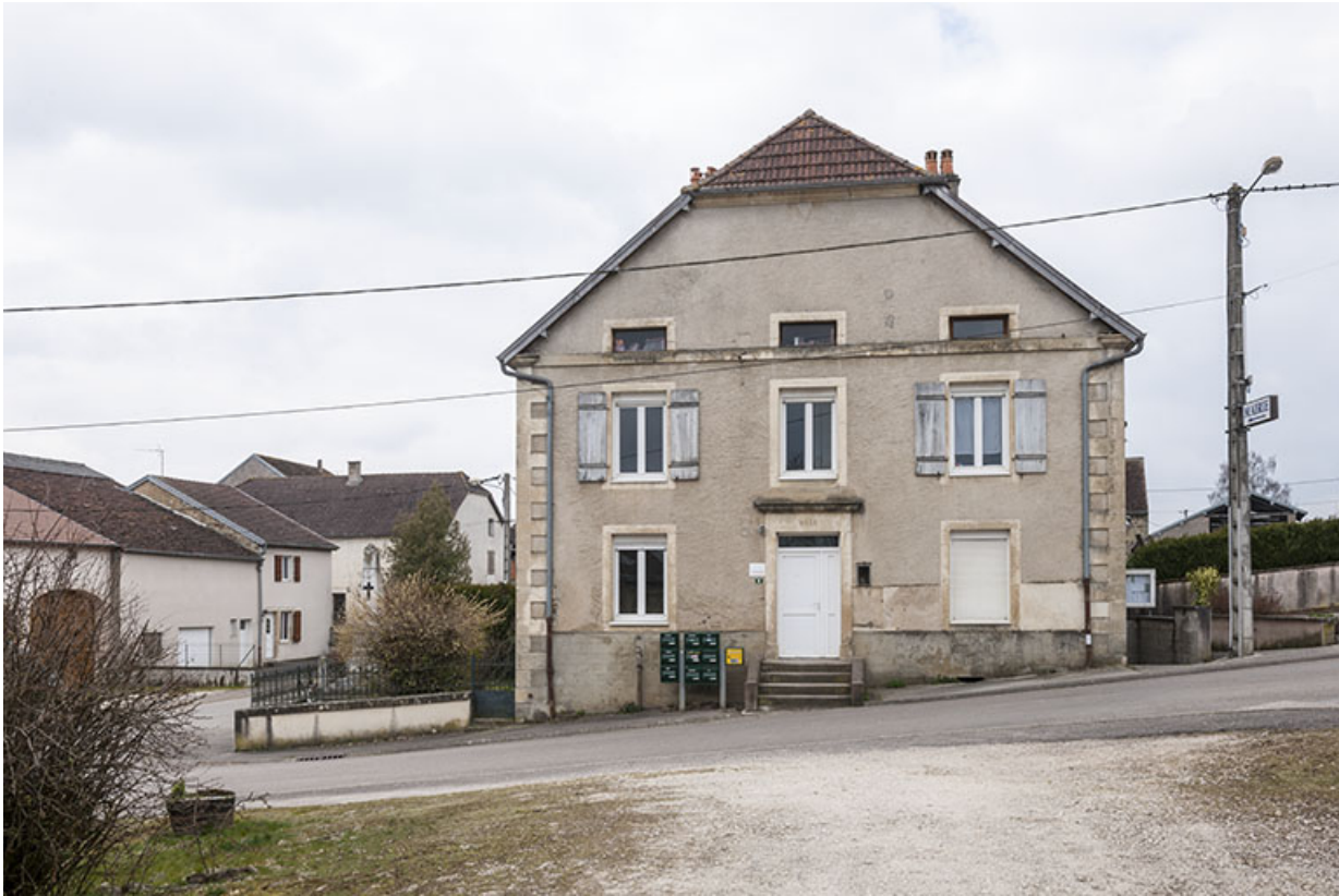
Vue sur la façade principale.
