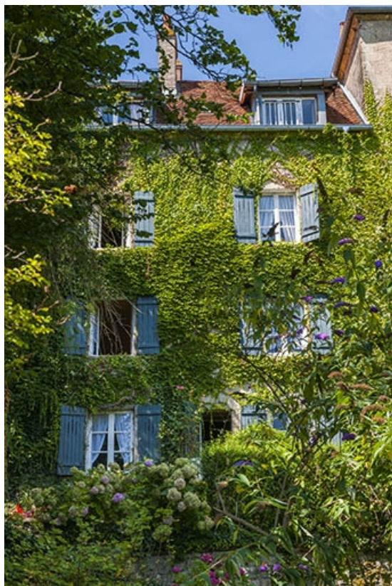
Façade postérieure, côté canal du Moulin.
