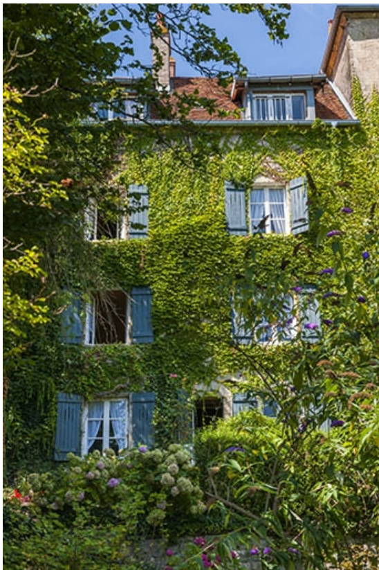
Façade postérieure, côté canal du Moulin.
