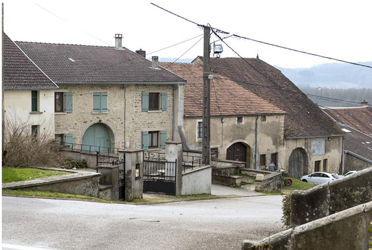
Alignement de fermes, haut de la Grande rue. 70, Aisey-et-Richecourt
