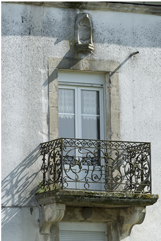
Détail d'une baie.
