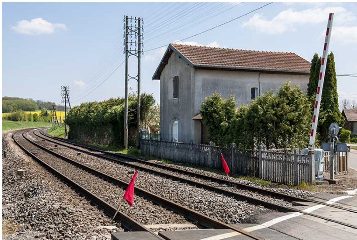
La voie ferrée longeant le village.
