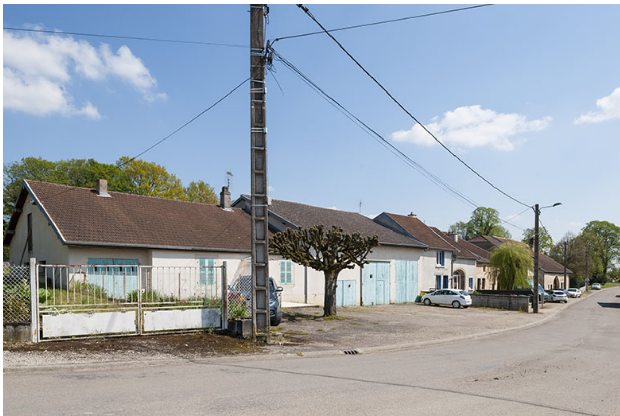
Maisons construites, rue du Patis.
