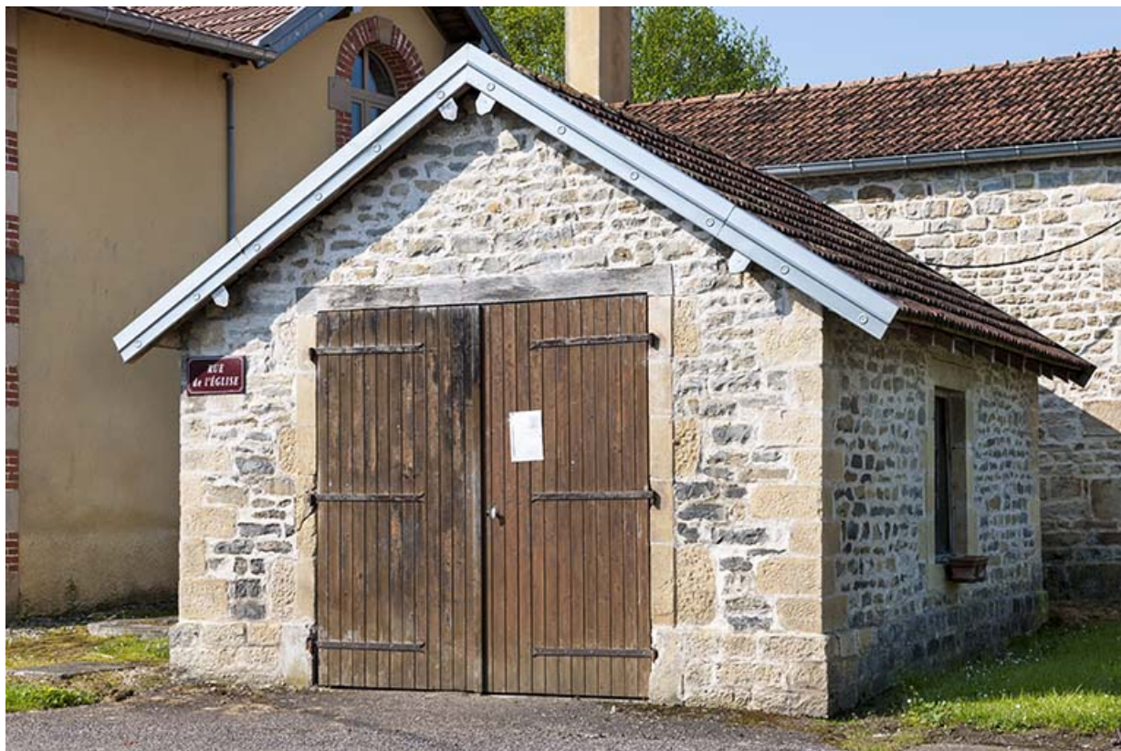
Local de la remise à pompe de la commune. 70, Montureux-lès-Baulay
