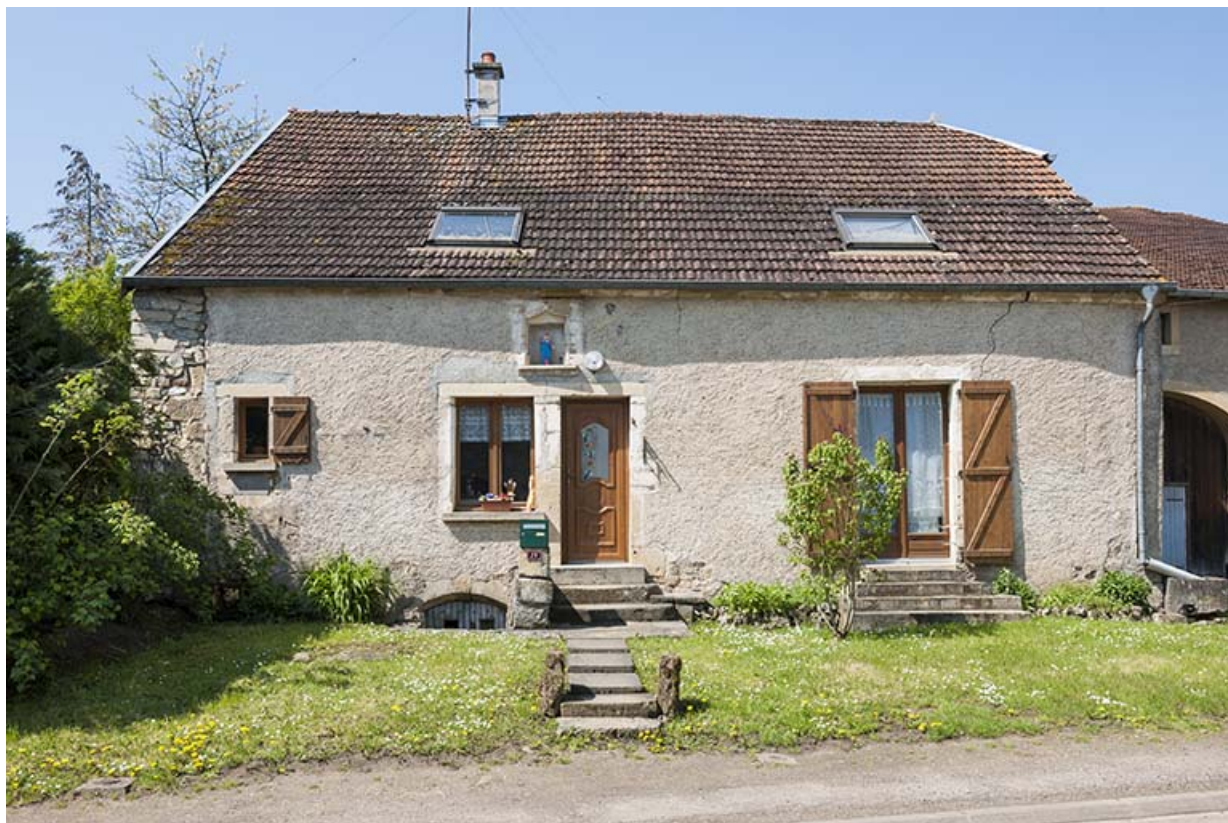
Ferme située Grande rue. 70, Montureux-lès-Baulay
