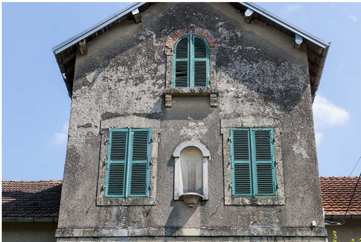
Détail sur la niche, façade principale.
