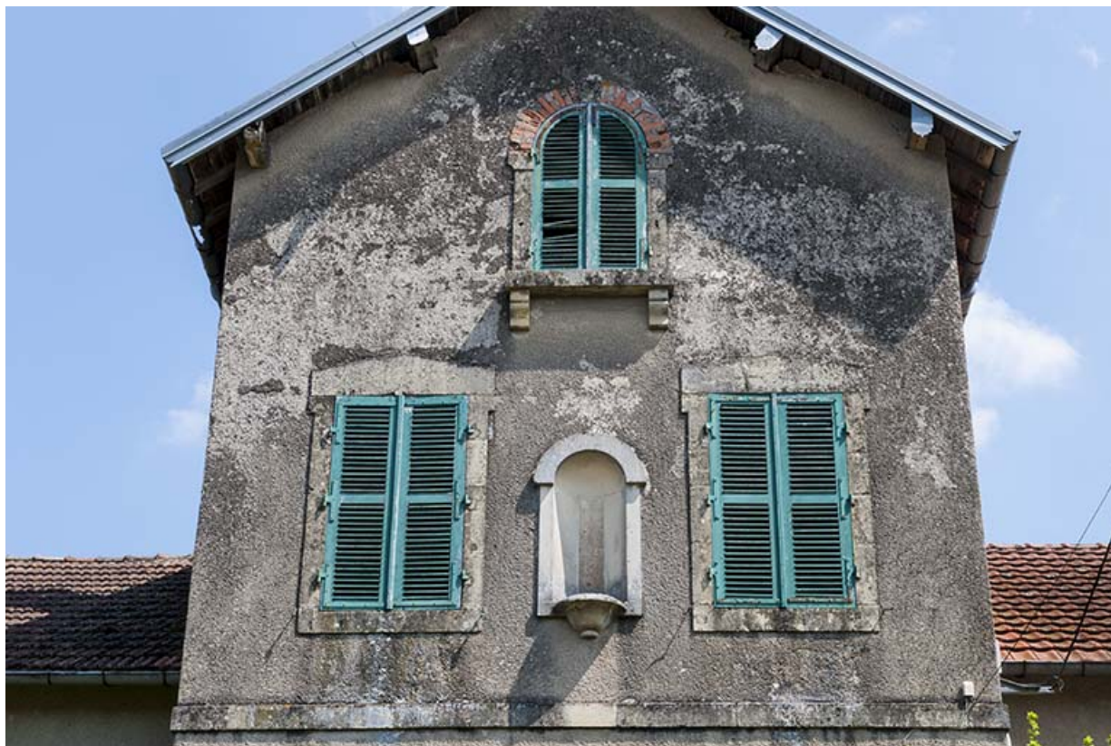
Détail sur la niche, façade principale.
