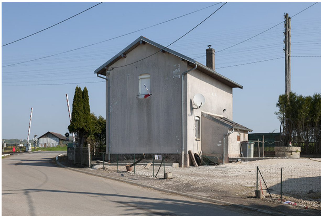
Maison garde-barrière de la commune.
