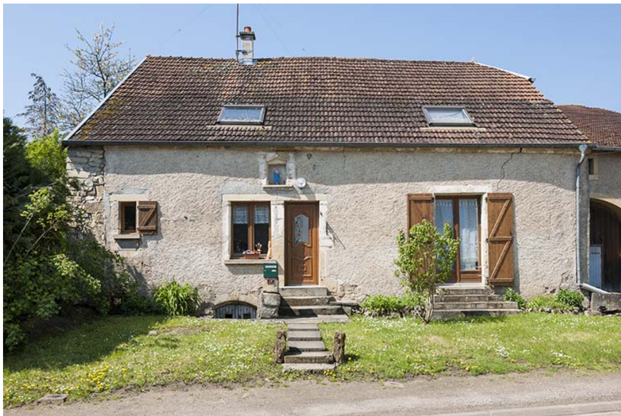
Ferme située Grande rue. 70, Montureux-lès-Baulay
