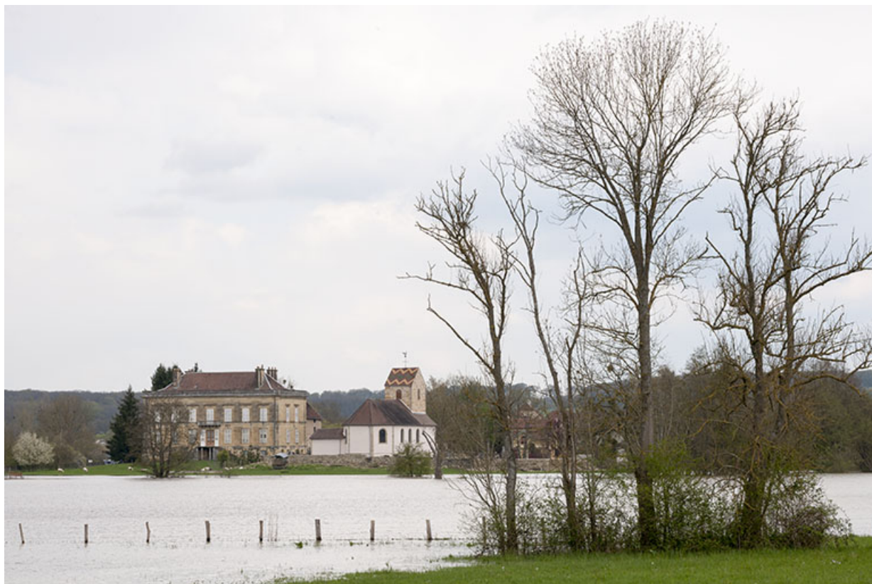
La commune lors d'une crue de la Saône.
