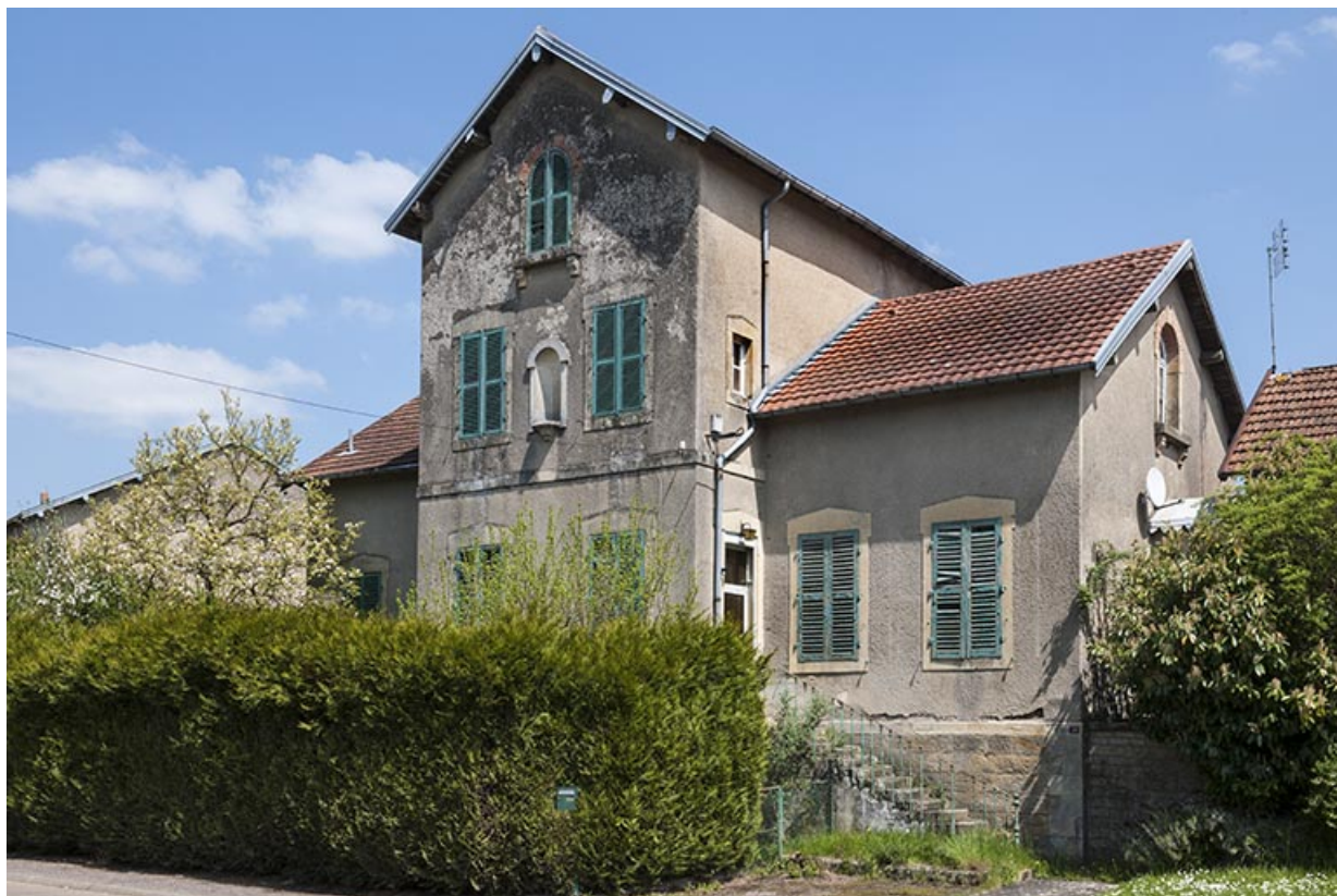
Ancienne maison des soeurs. 70, Montureux-lès-Baulay
