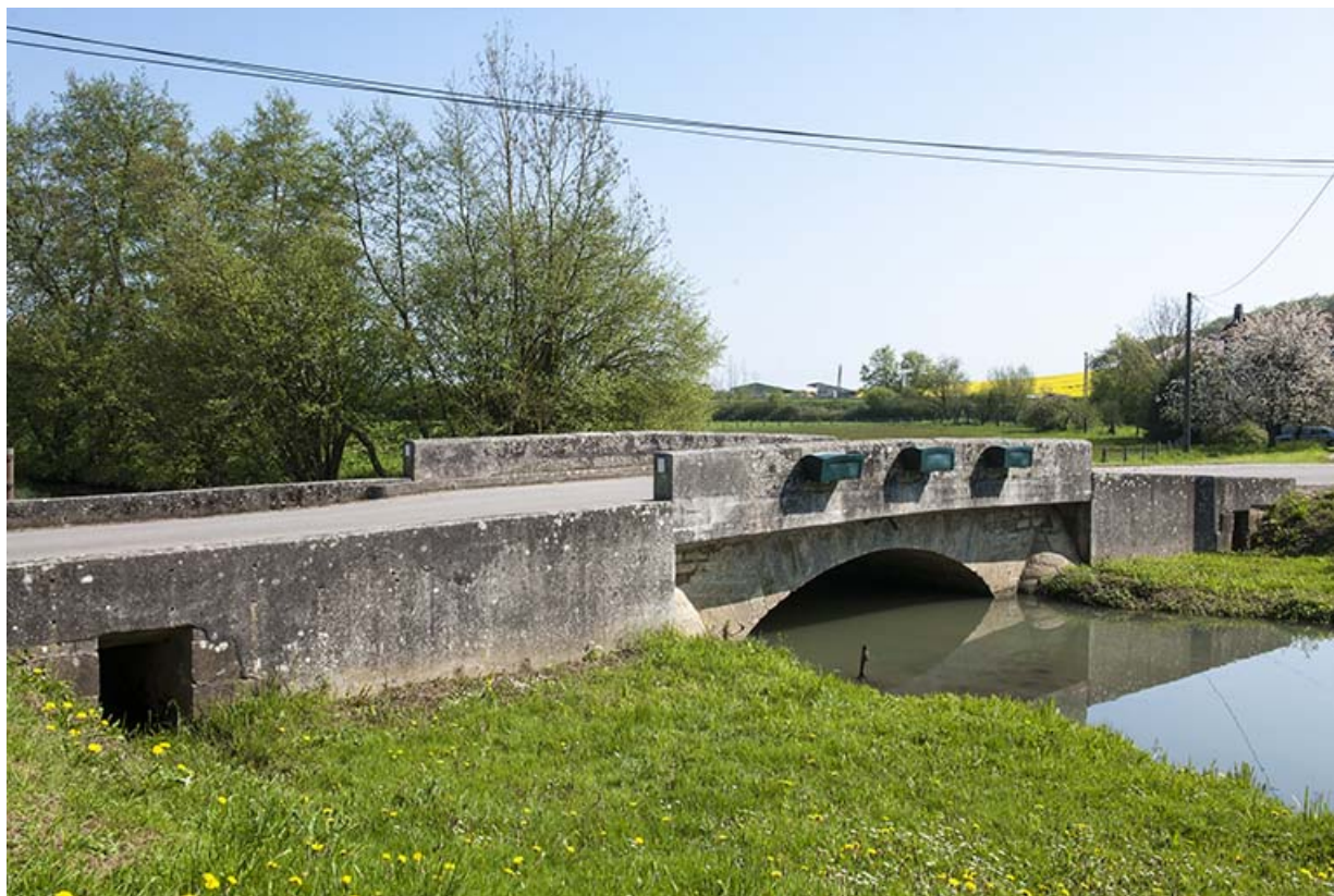
Le pont permettant de franchir le ruisseau. 70, Montureux-lès-Baulay
