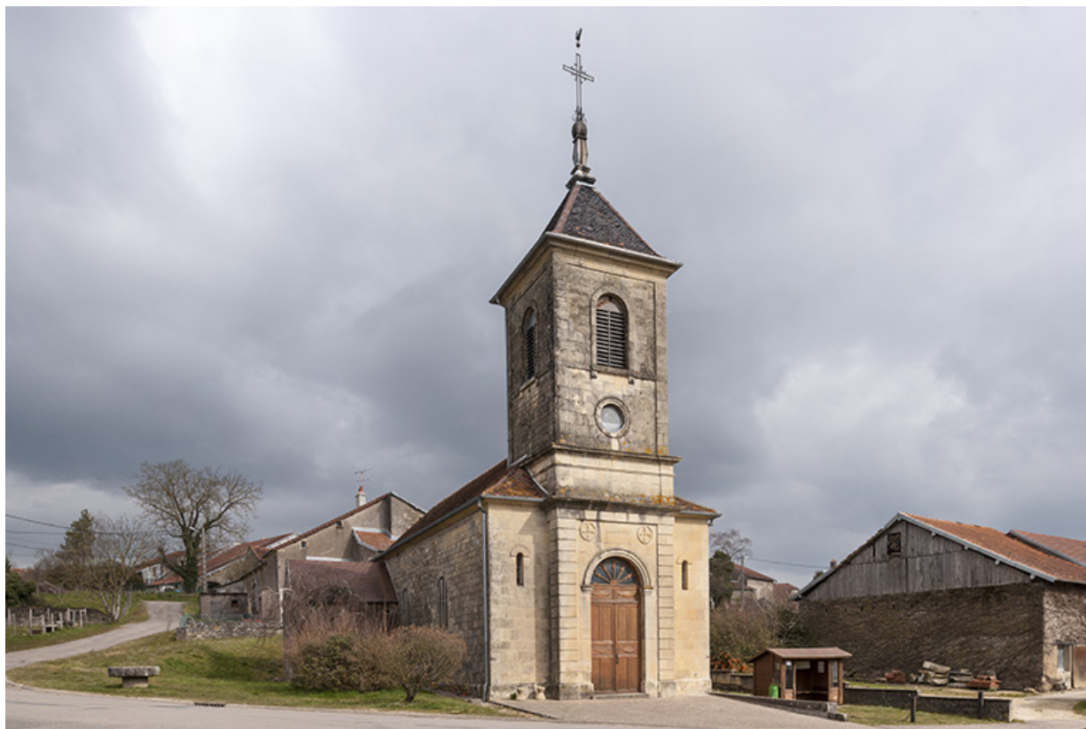
L'église et le bâti présent autour. 70, Fouchécourt
