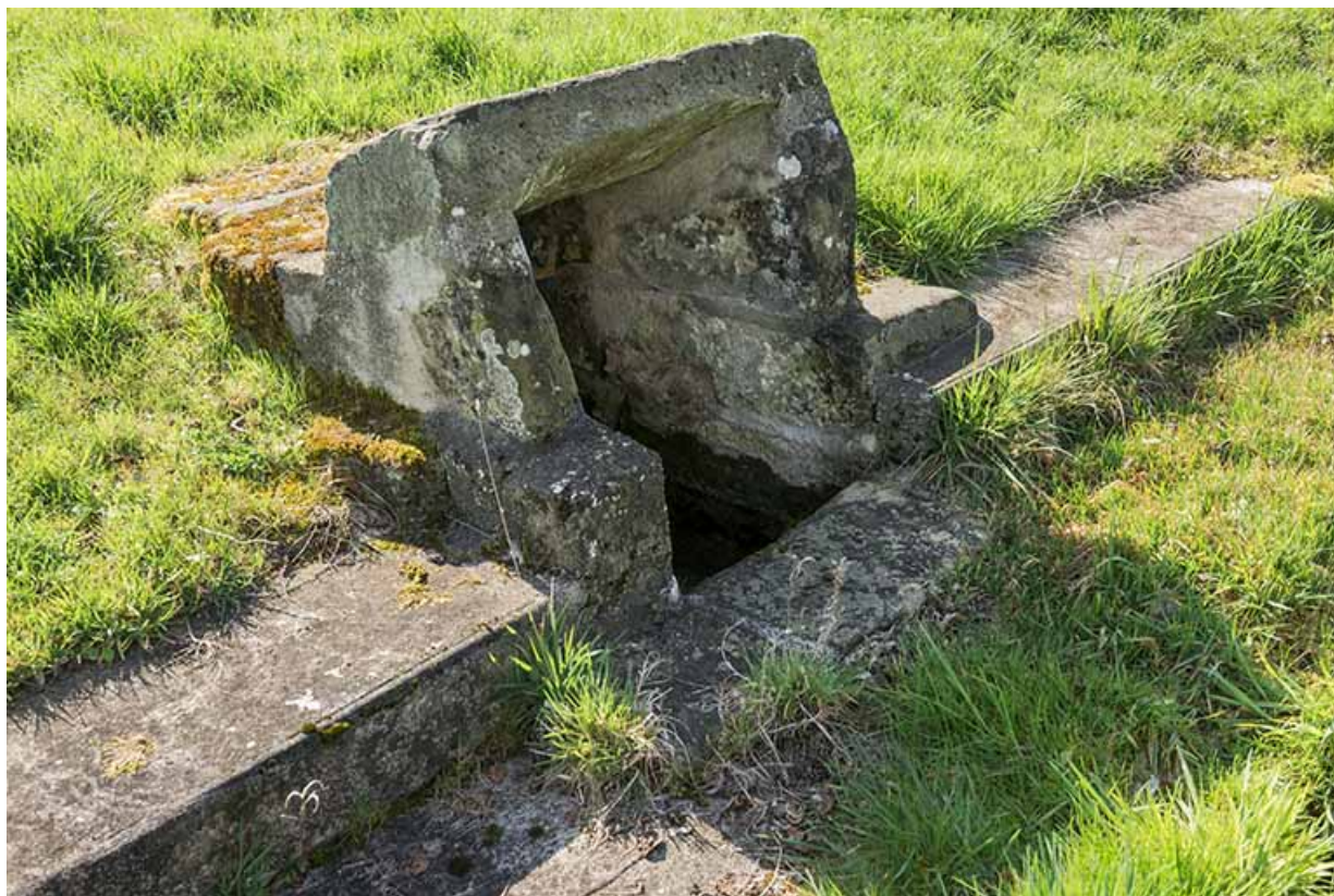
Fontaine d'alimentation du bassin.
