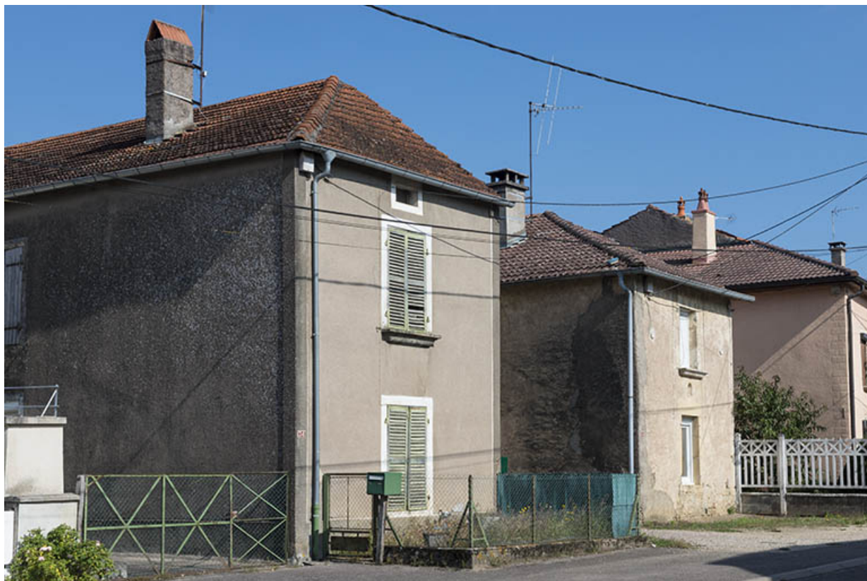
Alignement de fermes avec le logis en retour d'équerre.
