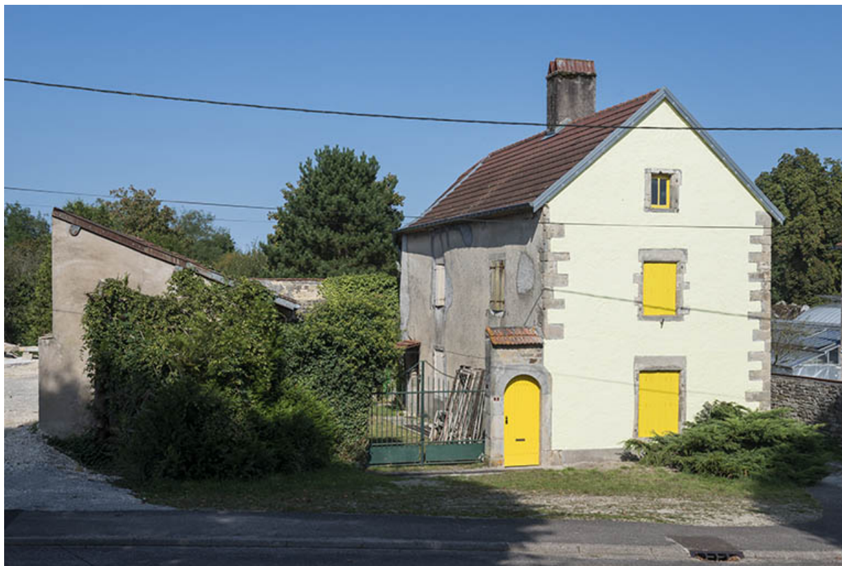
Ferme, rue Montgillard. 70, Gevigney-et-Mercey
