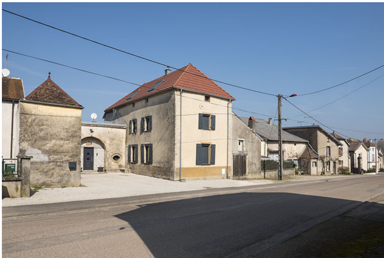
Vue générale, Grande rue. 70, Gevigney-et-Mercey
