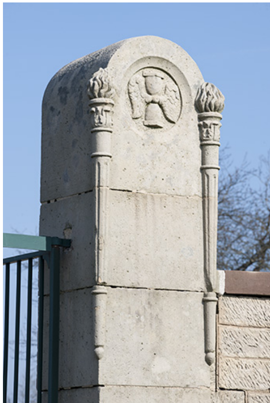
Détail d'un des piliers du portail.
