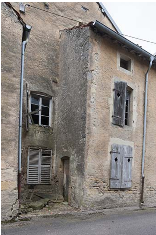
Détail du mur pignon.
