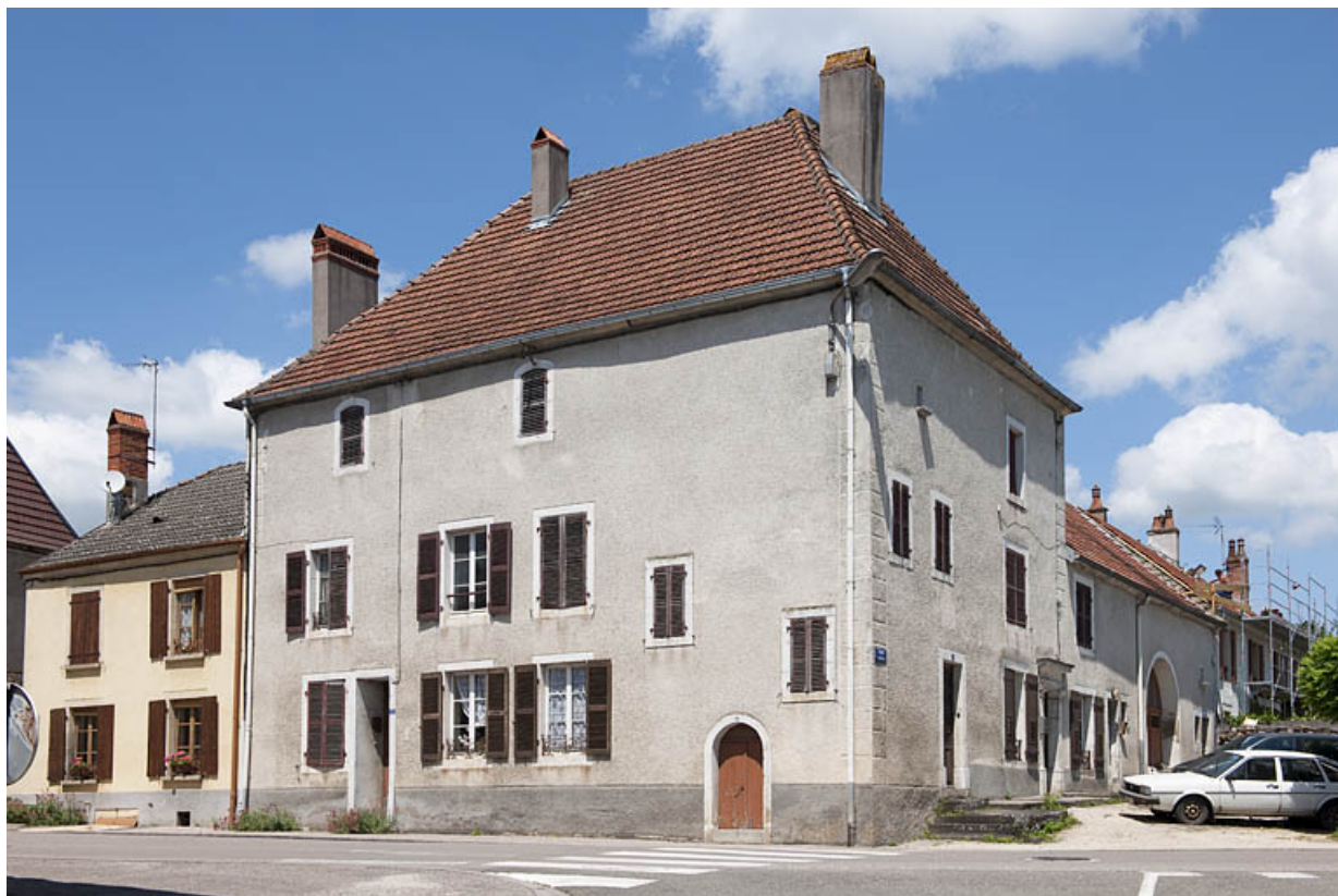
Vue d'ensemble à l'angle de la rue Arago et de la place Vauban.
