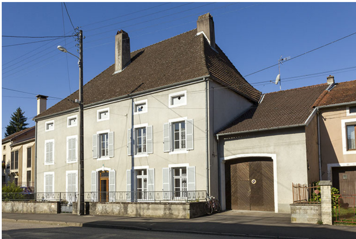
L'ancienne poste, 3 rue Emile Hauviller. 70, Corre
