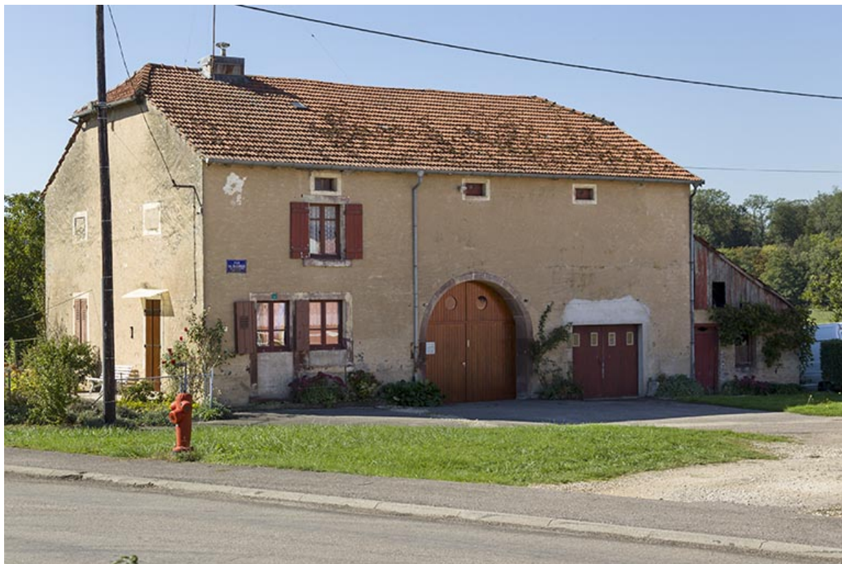
Vue de trois-quart de la façade antérieure nord-est de la ferme située 4 rue du faubourg Louis Boulanger. 70, Corre
