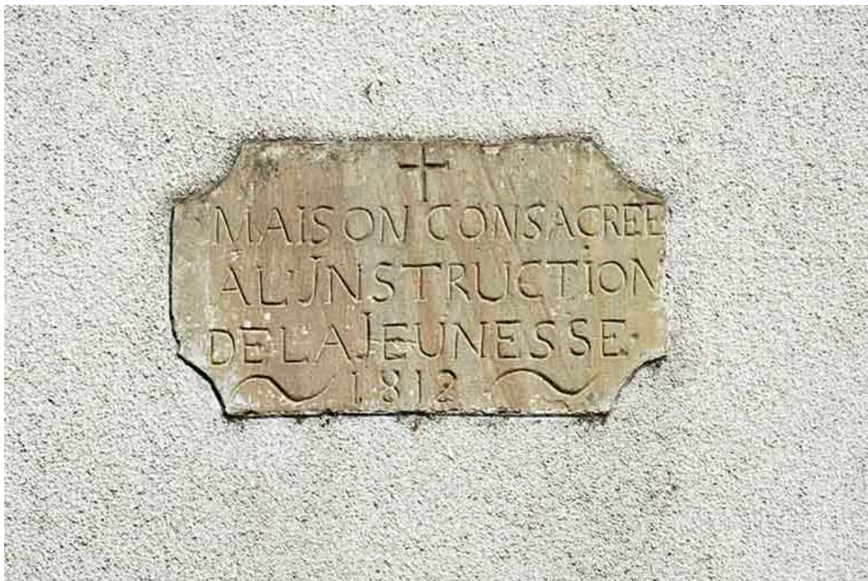
Détail : Maison 2 rue Jean Monnasson, à l'angle de la rue Emile Hauviller. 70, Corre
