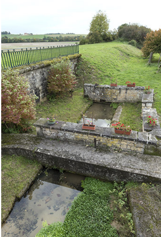
Ancien lavoir à l'ouest du village, rue Maurice Boulanger. 70, Corre
