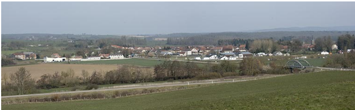
Vue générale depuis le sud-ouest.
