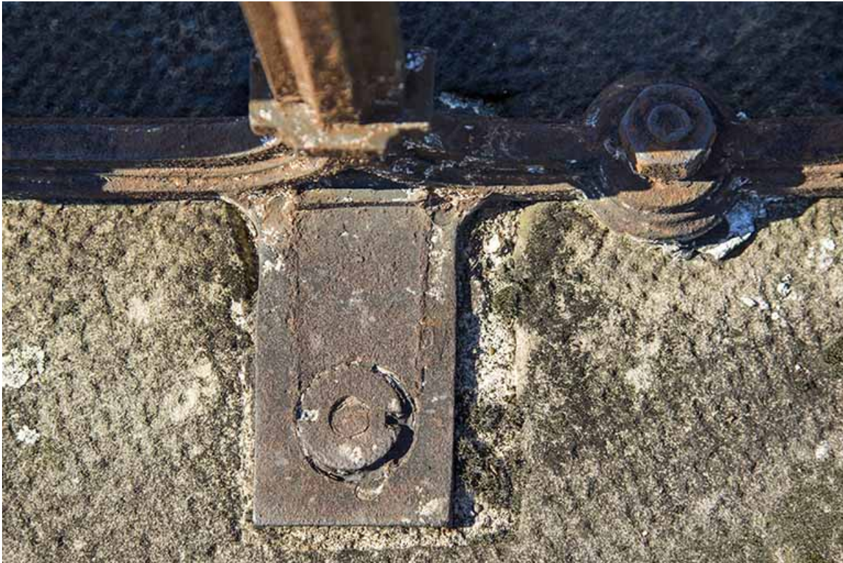
Détail de l'assemblage du garde-corps sur le tablier du viaduc. 70, Passavant-la-Rochère
