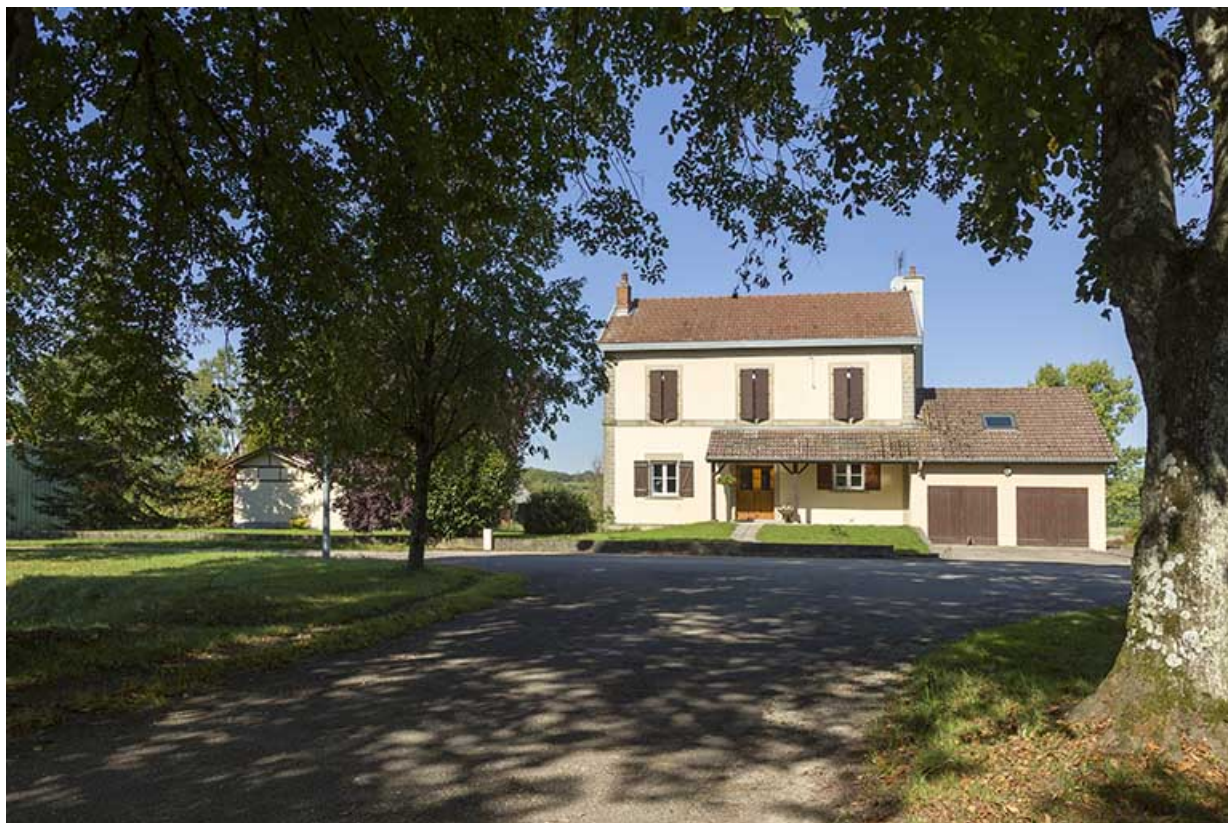
Façade sud-est de l'ancienne gare.
