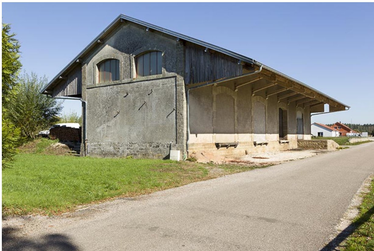
Vue de trois-quart sud-ouest de l'ancienne halle à marchandises de l'ancienne gare. 70, Corre avenue de la gare
