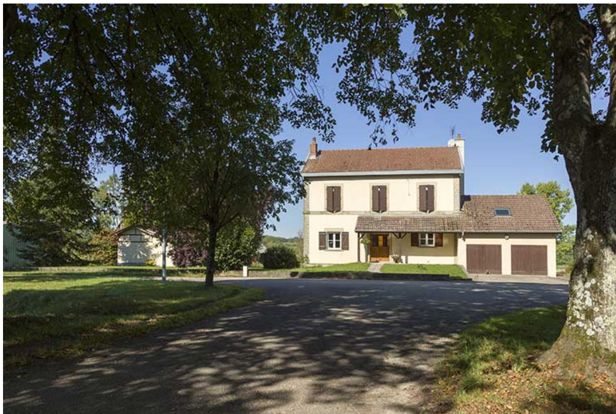
Façade sud-est de l'ancienne gare.
