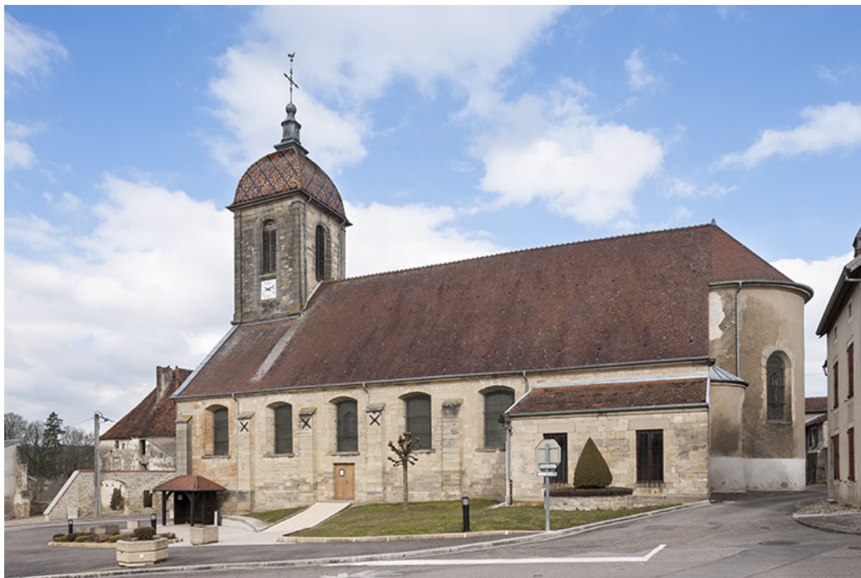
Vue sur la façade sud. 70, Ormoy rue de l' Église
