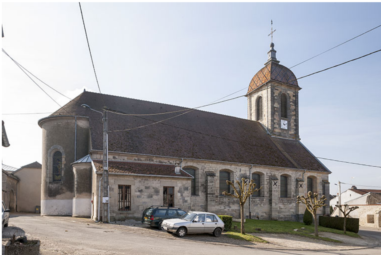
Vue sur la façade nord.
