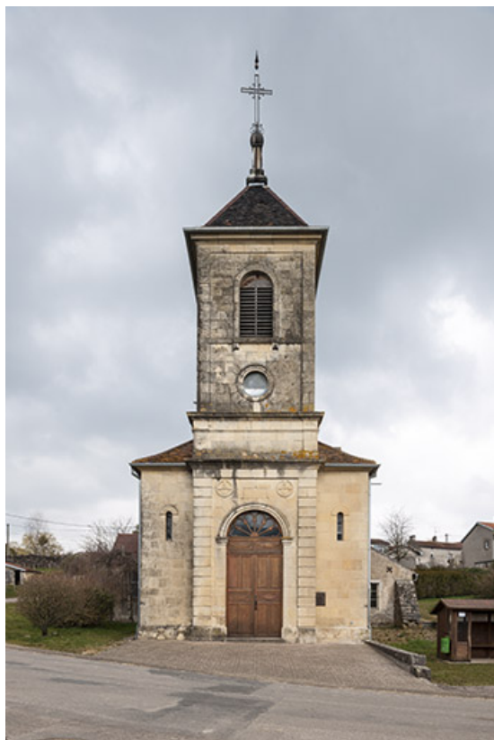
Vue sur la façade principale.
