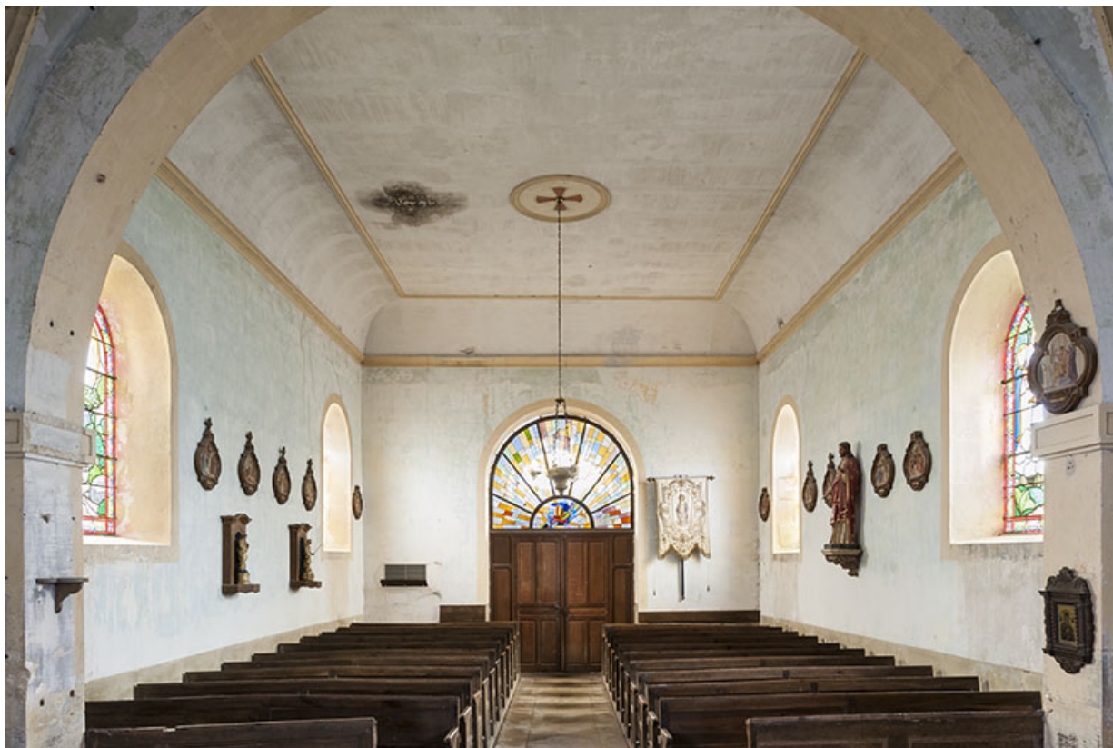
Vue générale depuis le chœur.
