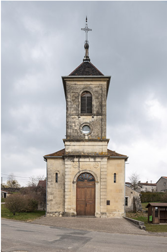
Vue sur la façade principale.
