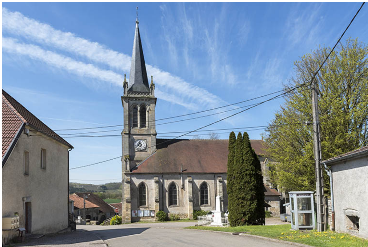
Vue générale depuis la rue du Petit Mont.
