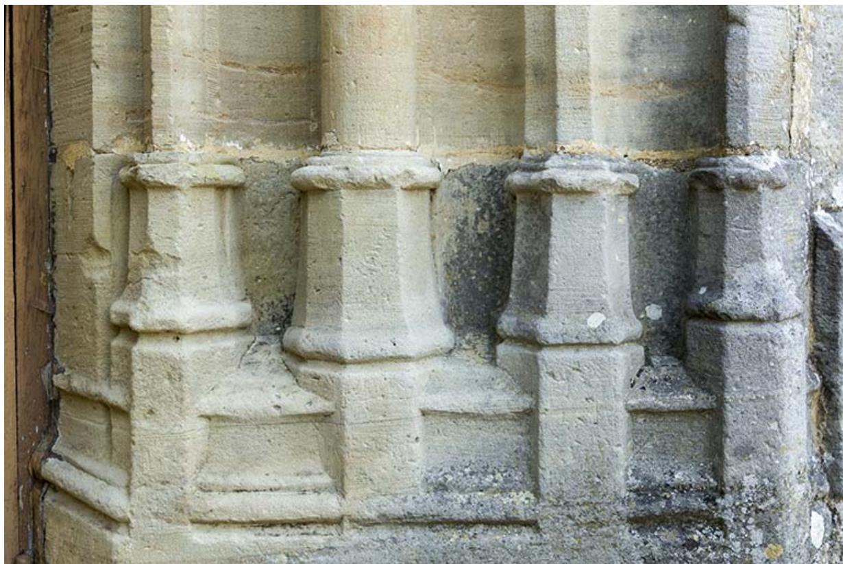
Détail de la base du piedroit droit.
