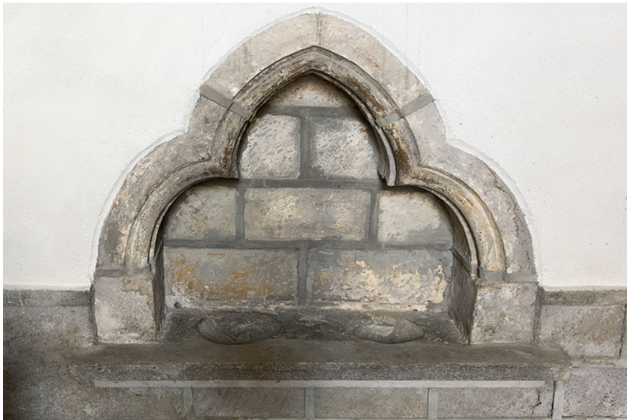
Détail : niche trilobée à droite du chœur.
