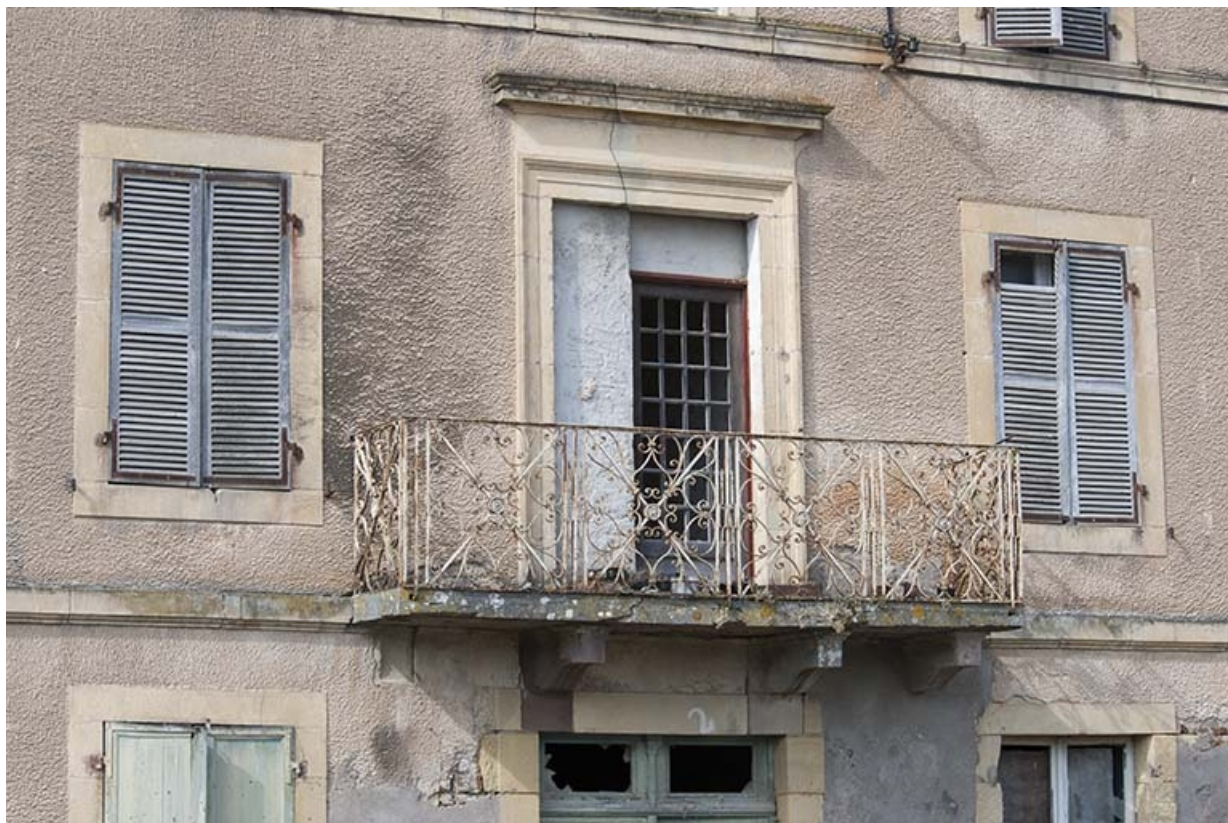
Façade antérieure, détail : le balconnet du premier étage.
