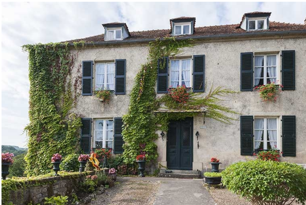
Façade antérieure sur cour.
