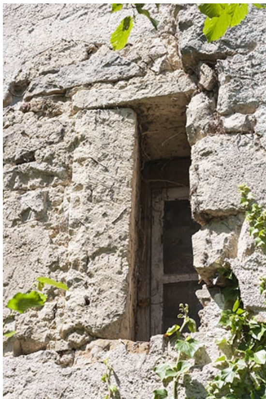
Façade postérieure, détail de la baie du rez-de-chaussée côté canal du Moulin. 70, Faverney, 2 place Vauban
