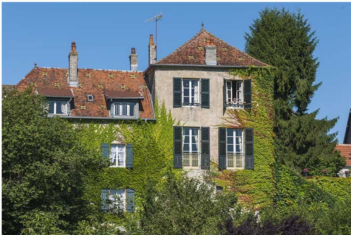
Vue d'ensemble des maisons 2 place Vauban et 1 rue d'Enfer, côté canal du Moulin. 70, Faverney, 2 place Vauban
