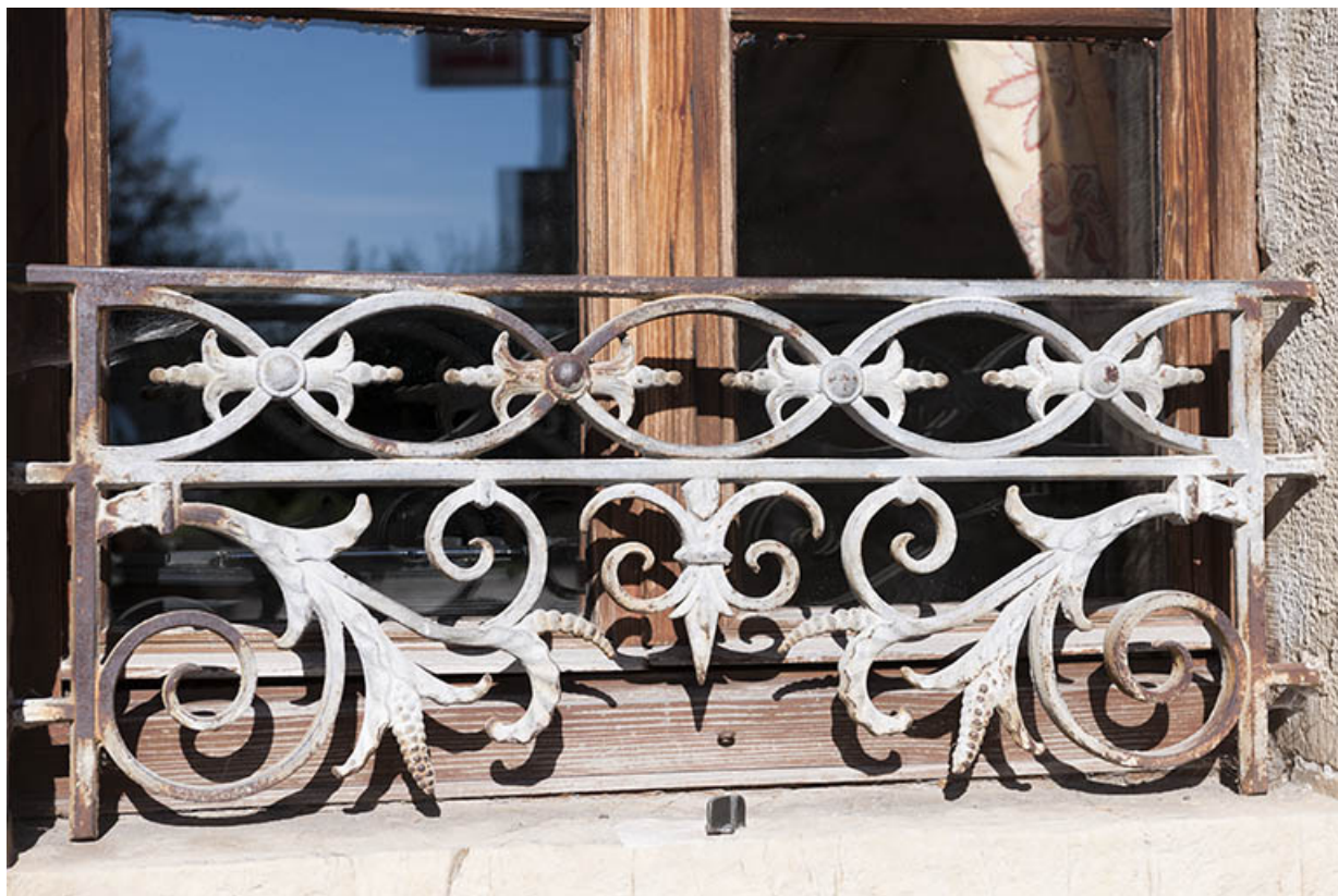
Façade sur la rue des Glacis, détail : le garde-corps en fonte d'une fenêtre du rez-de-chaussée. 70, Faverney, 3 rue des Glacis
