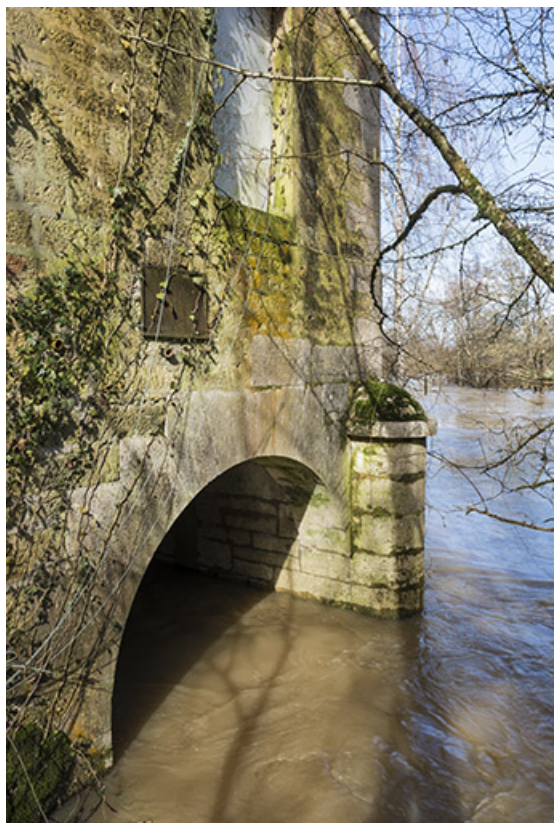
Canal de fuite du moulin.
