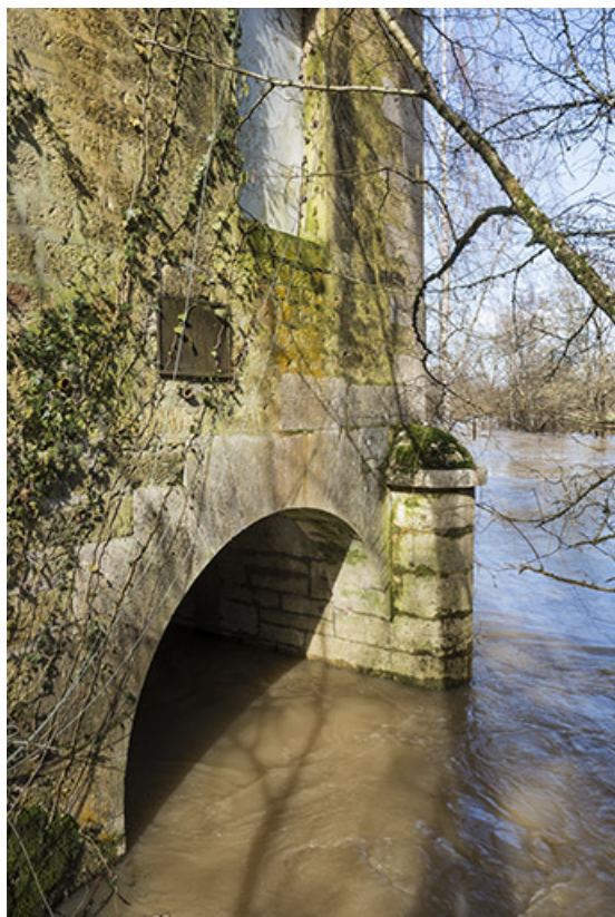
Canal de fuite du moulin.
