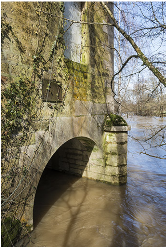
Canal de fuite du moulin. 70, Gevigney-et-Mercey
