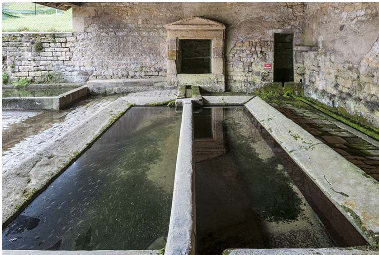
Les bassins du lavoire, rue de la Fontaine. 70, Fouchécourt
