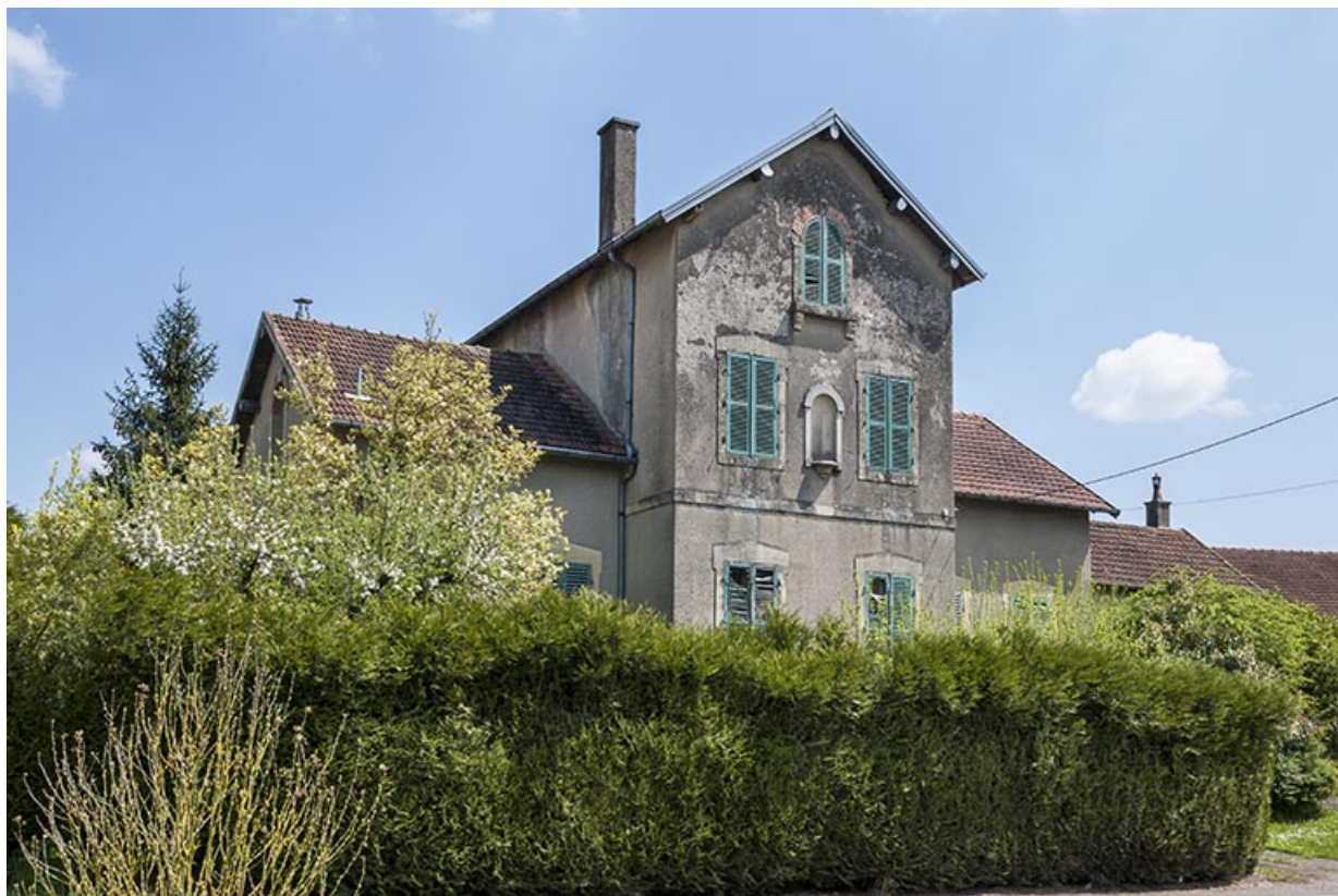
Ancienne maison des soeurs. 70, Montureux-lès-Baulay
