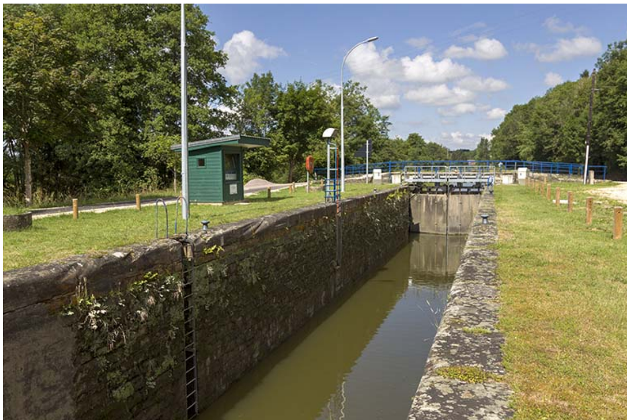
L'écluse et son poste de commande.
