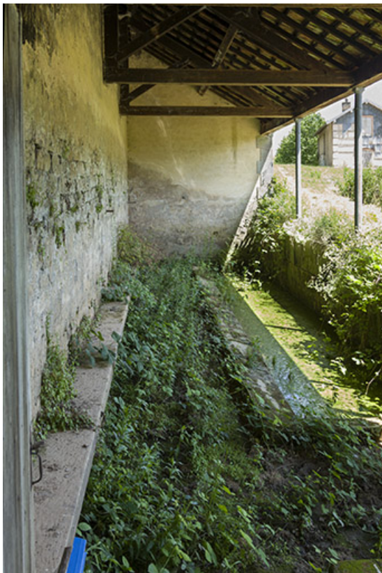
Intérieur du lavoir.
