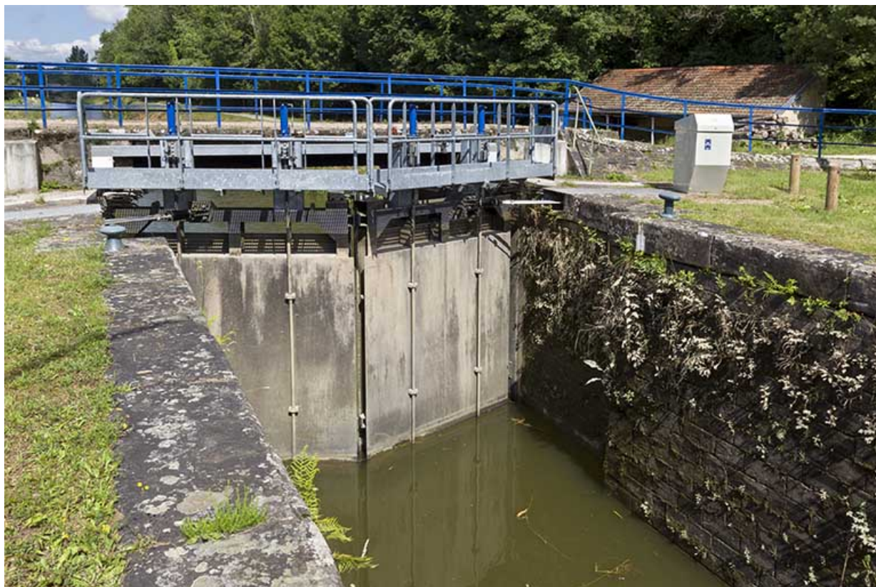
Les portes de l'écluse, busquées vers l'amont. 70, Selles
