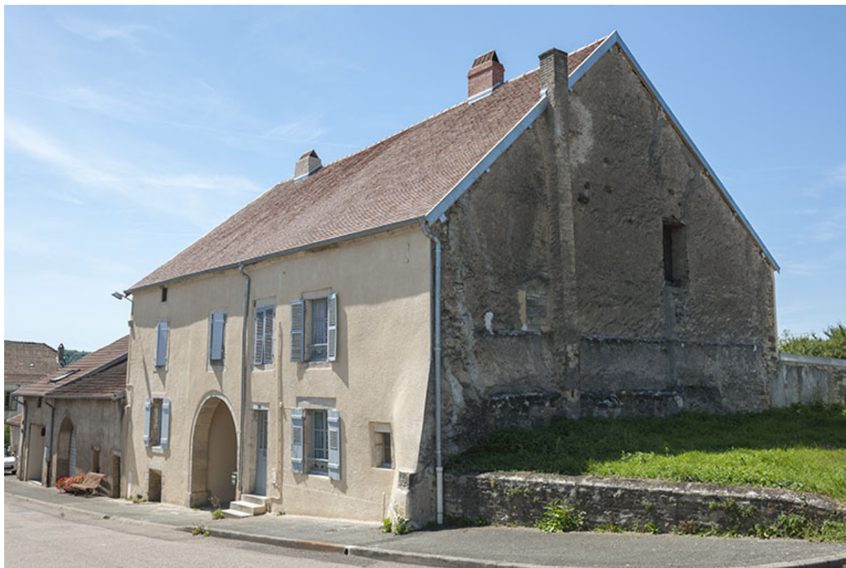
Vue générale de trois quart droite (rue du Général Rebillot et rue Catinat). 70, Faverney, 3, 5 rue du Général Rebillot
