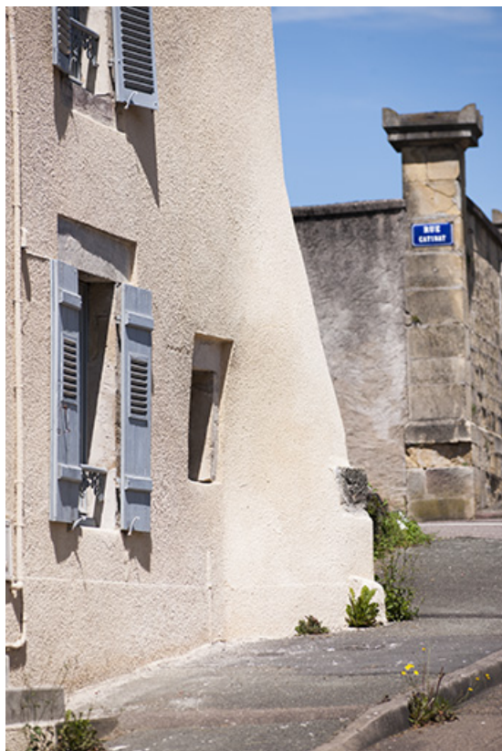
Façade antérieure : le mur à l'angle des rues du Général Rebillot et Catinat a gardé le souvenir du rempart. 70, Faverney, 3, 5 rue du Général Rebillot
