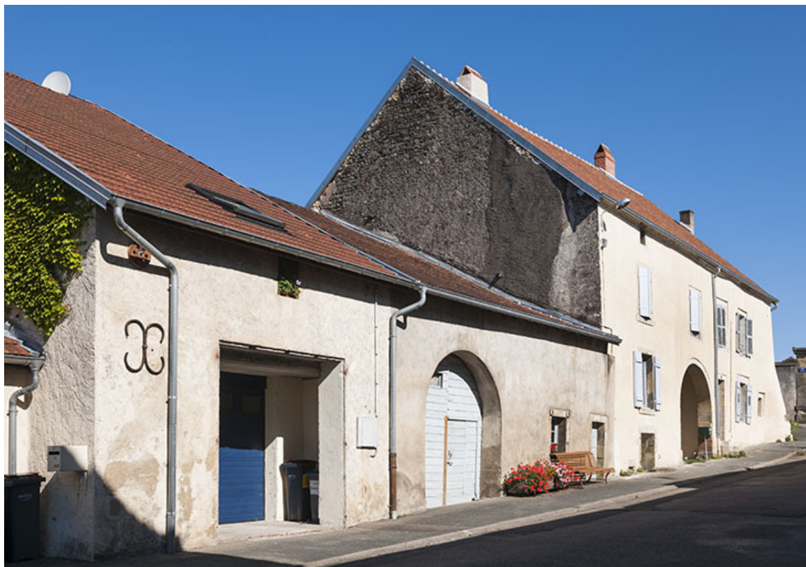
Vue générale depuis la rue du Général Rebillot.
