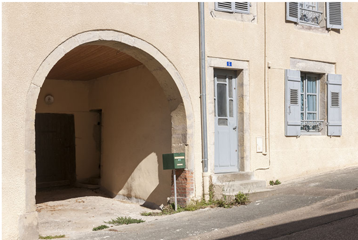
Façade antérieure : le porche conduisant au logis à droite et à l'étable à vaches au fond du passage couvert. 70, Faverney, 3, 5 rue du Général Rebillot
