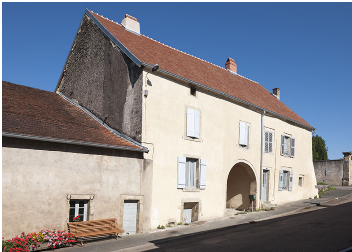
Vue rapprochée depuis la rue du Général Rebillot.
