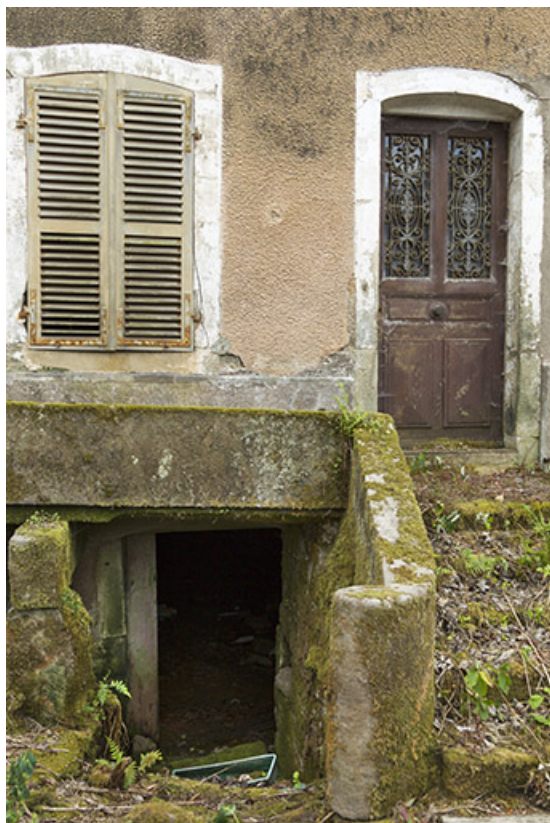
Entrée de la cave depuis la façade antérieure.
