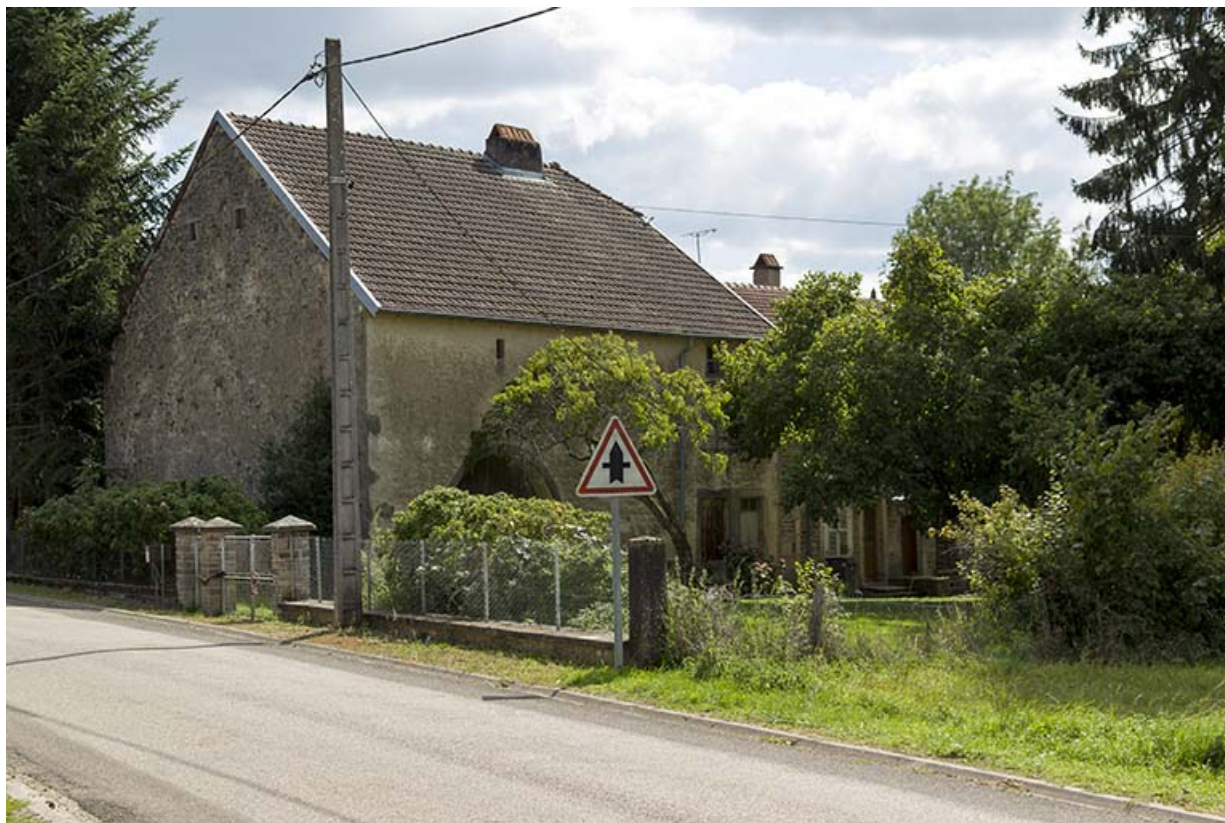
Ferme avec mur pignon perpendiculaire à la voie publique. 70, Pont-du-Bois
