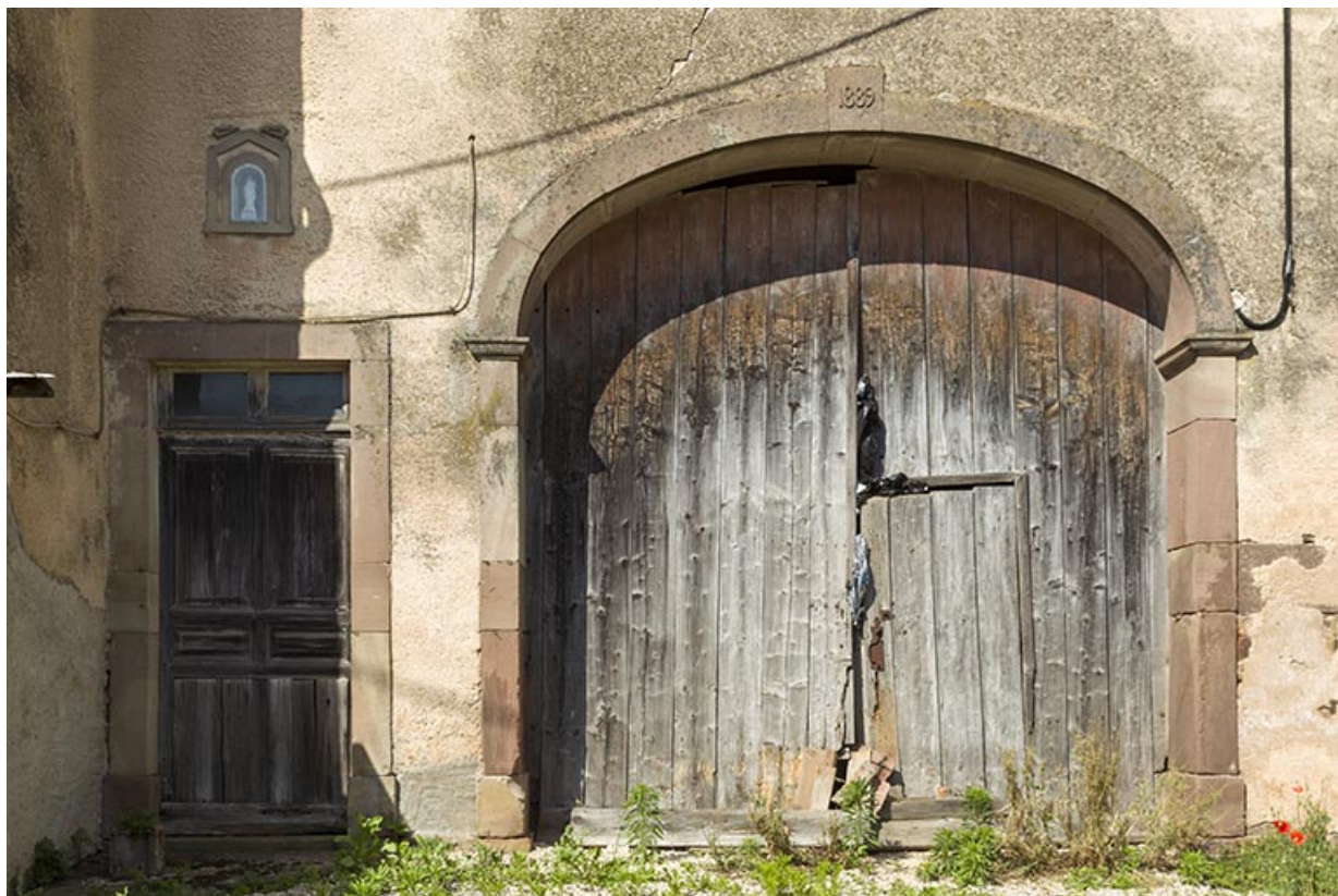
Portes de grange et du logis d'une ferme. 70, Pont-du-Bois
