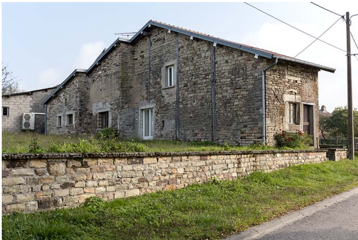
Ferme en L (2). 70, Pont-du-Bois
