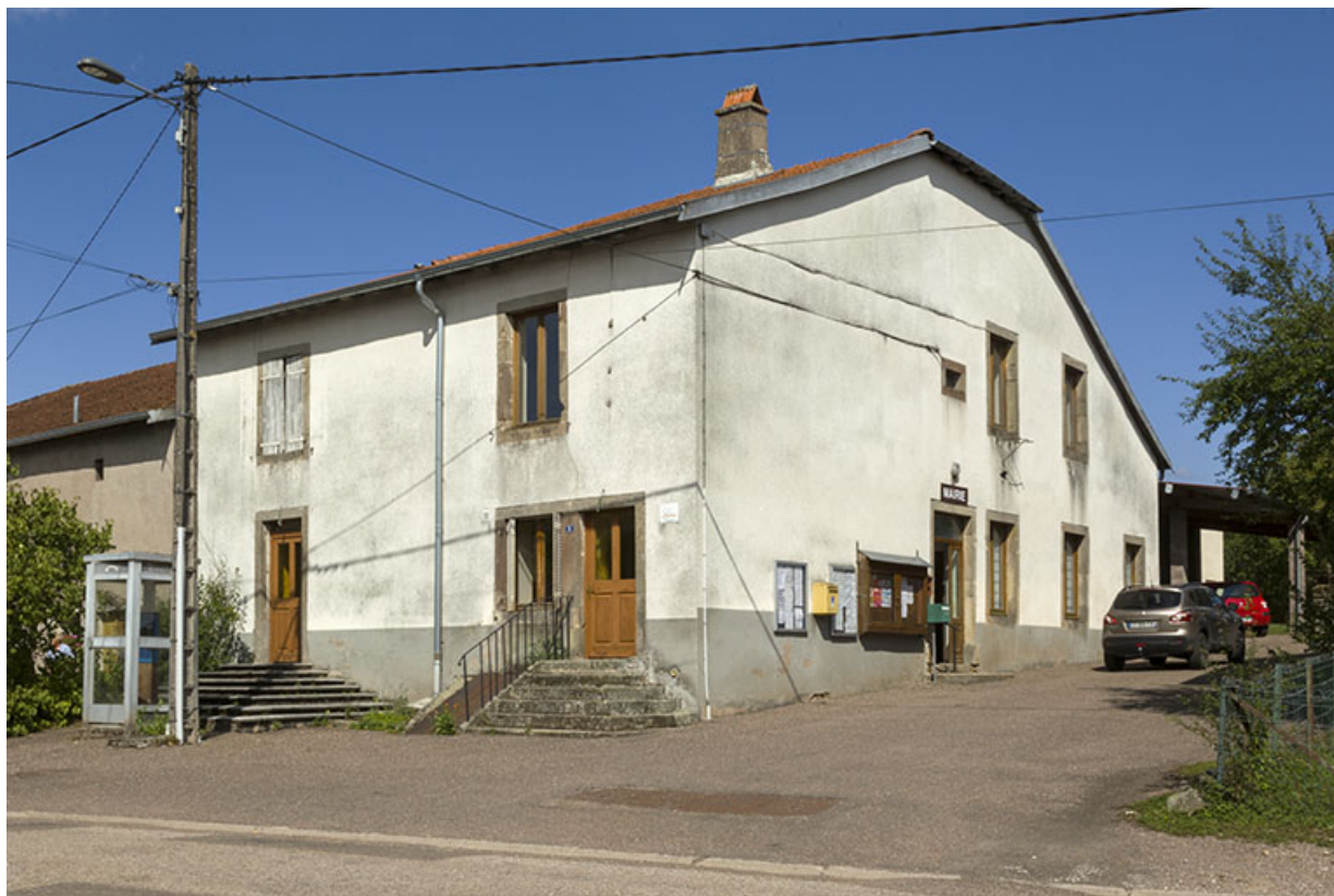
Ancienne école des garçons et mairie actuelle. 70, Pont-du-Bois
