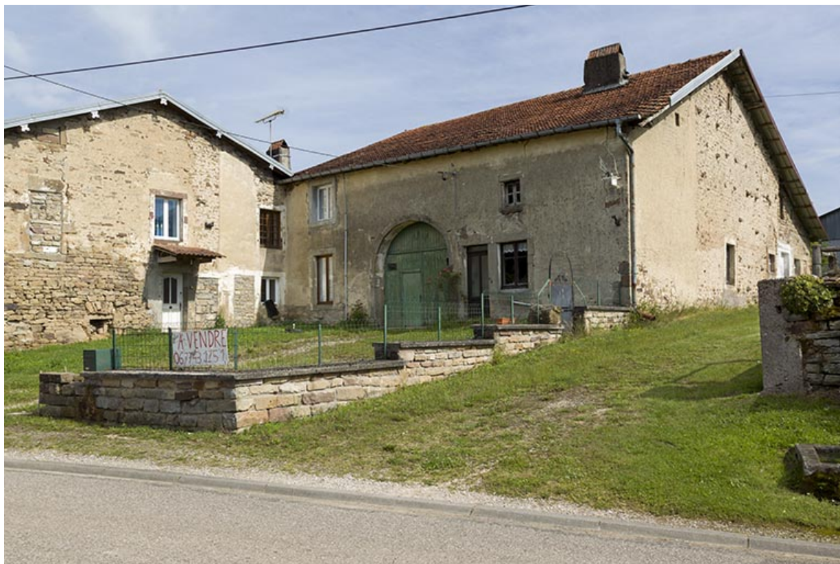
Ferme en L (1). 70, Pont-du-Bois
