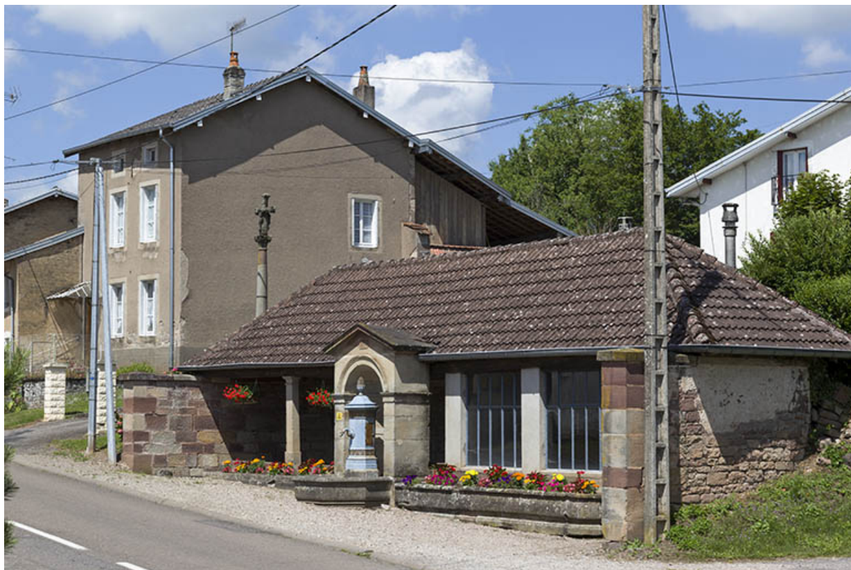
Vue d'ensemble depuis la Grande rue.
