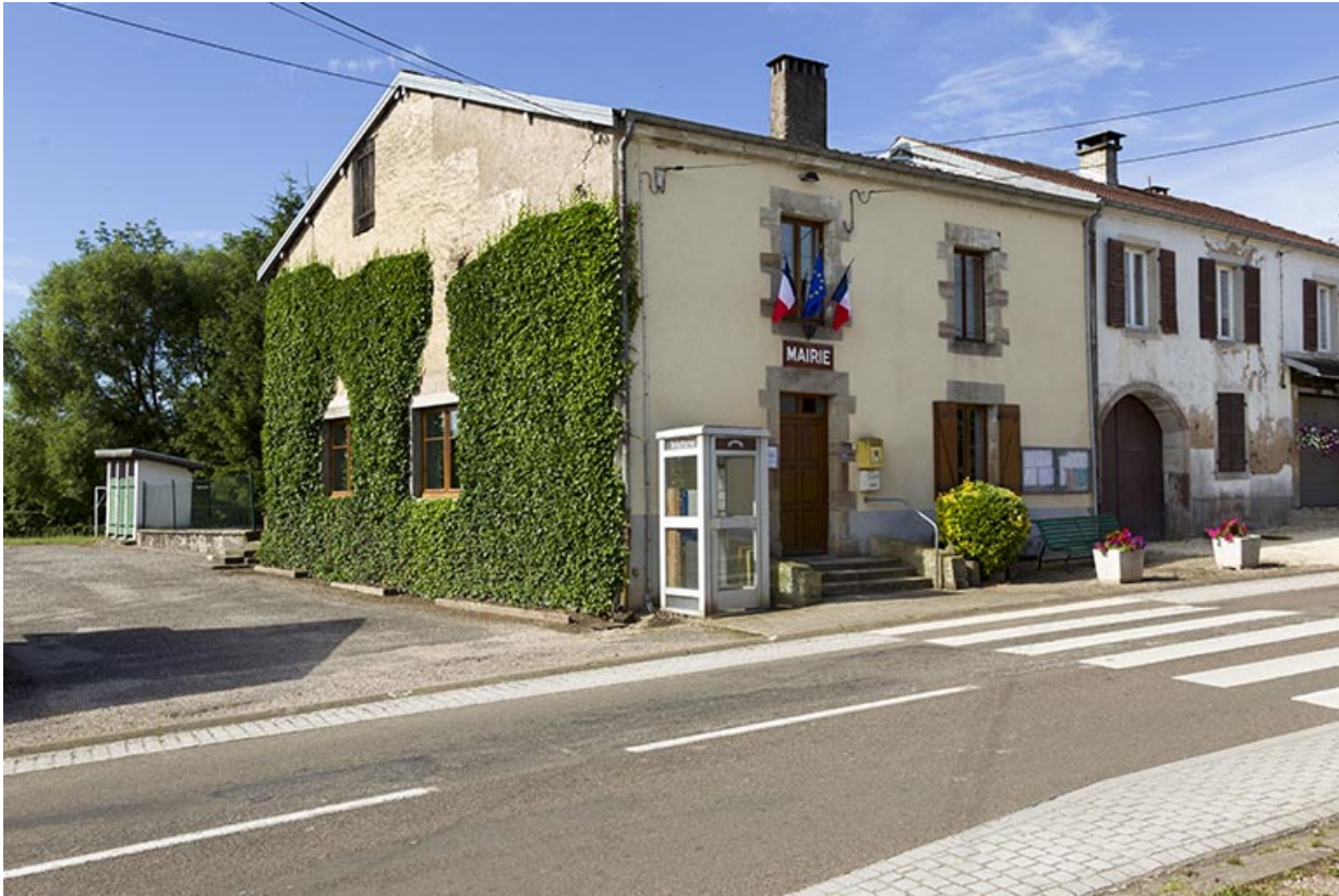
Façades antérieur et latérale gauche.
