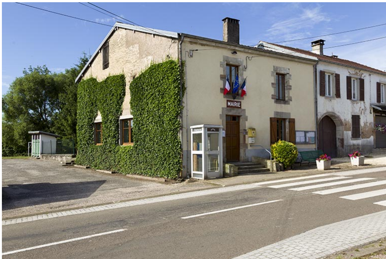
Façades antérieur et latérale gauche.
