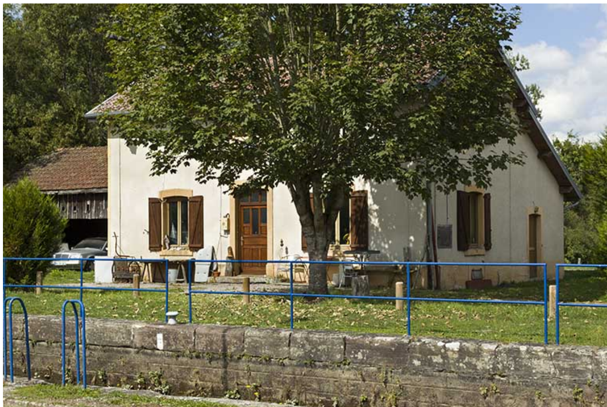
La maison d'éclusier, écluse n°39.
