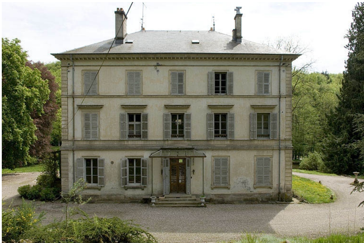
Façade sud de la demeure patronale.
