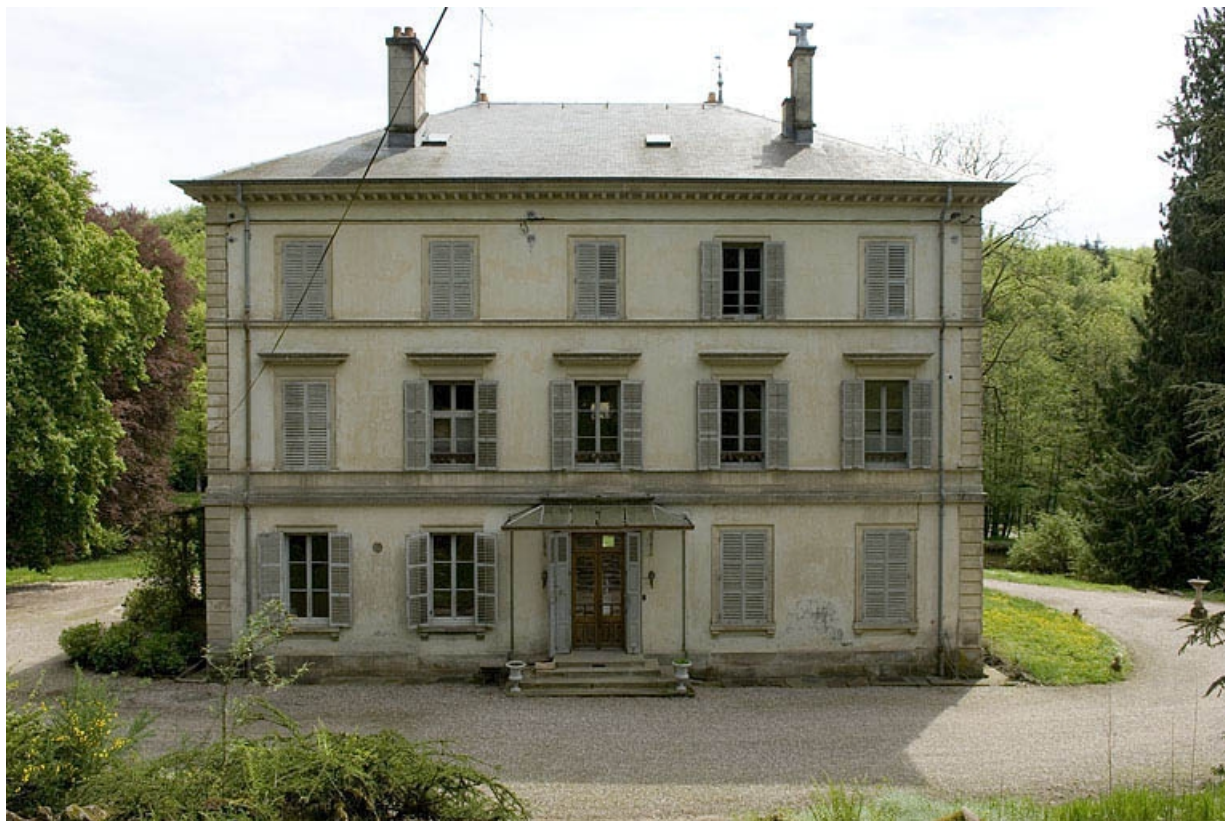
Façade sud de la demeure patronale.
