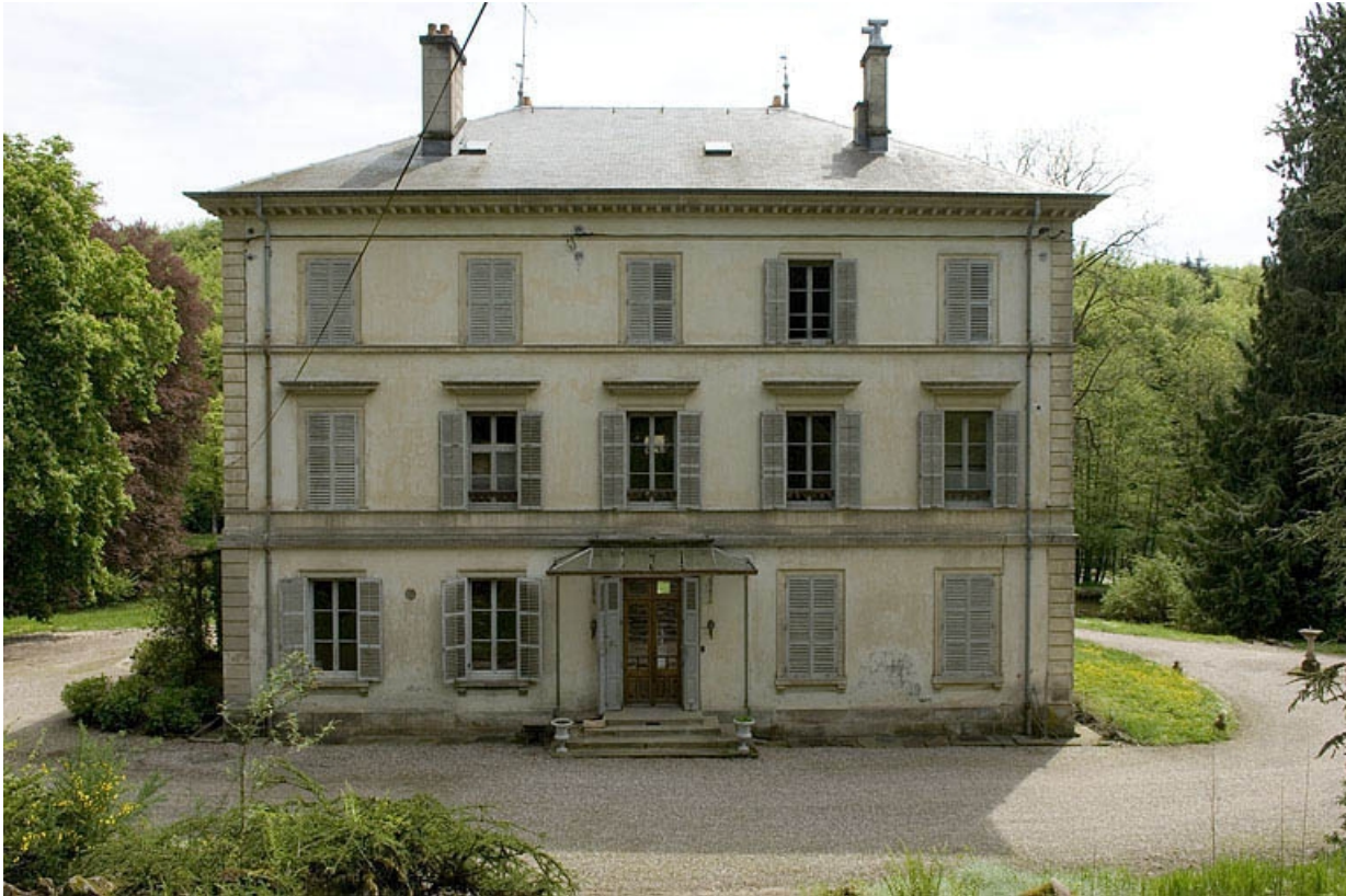
Façade sud de la demeure patronale.
