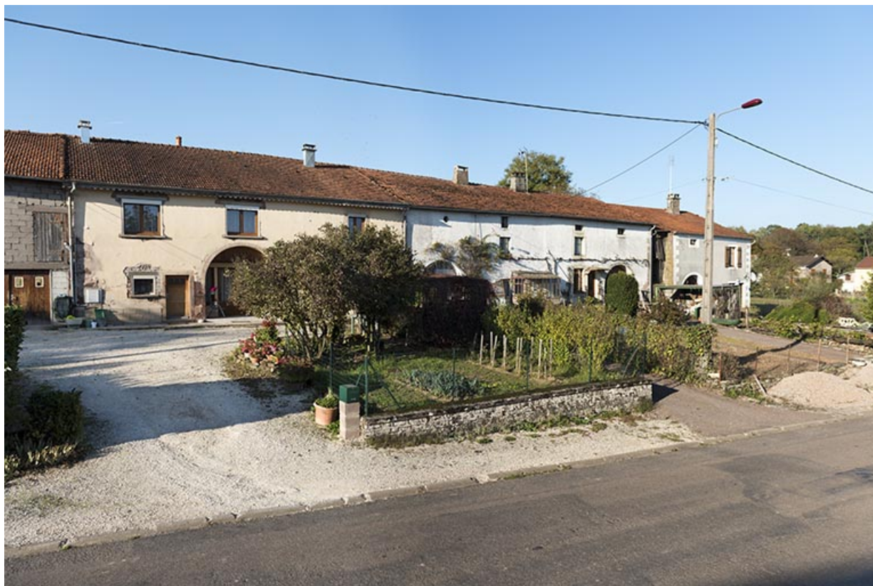
Alignement de fermes, Grande rue. 70, Ambiévillers
