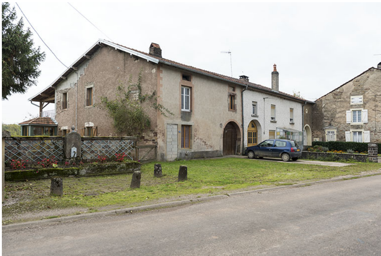
Alignement de fermes, Grande rue. 70, Ambiévillers
