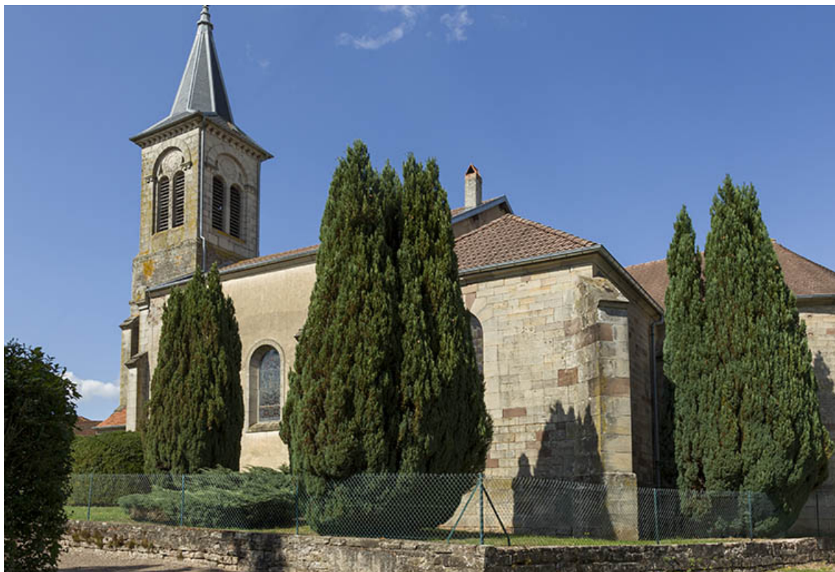
Façade latérale sud de la nef.
