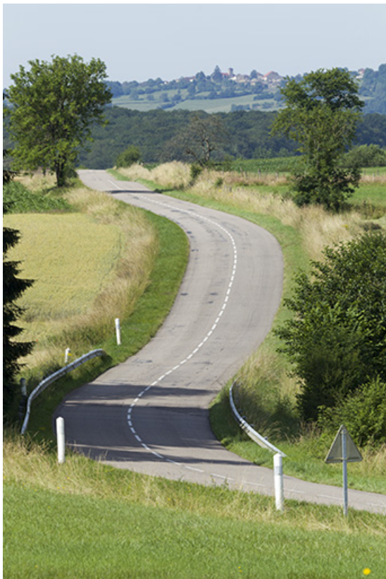
La route départementale 434.
