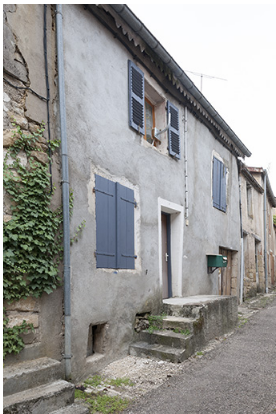
Maison, 2 rue d'Enfer : maison en rez-de-chaussée surélevé sur cave. 70, Faverney
