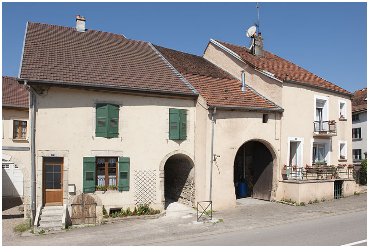
Maison, 7 Grande Rue : autre exemple de maison à rez-de-chaussée surélevé sur cave. 70, Faverney
