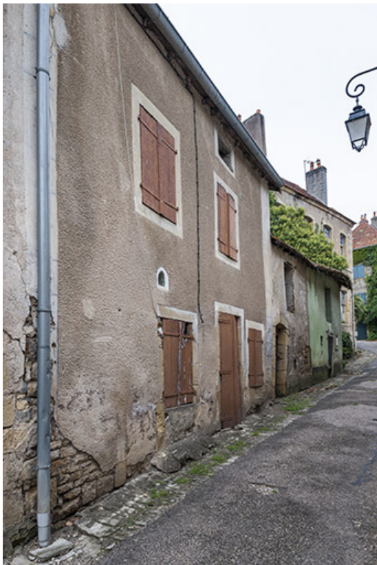
Maison, rue d'Enfer : exemple de maison à un étage carré et un étage de comble éclairé par une baie oblongue. 70, Faverney
