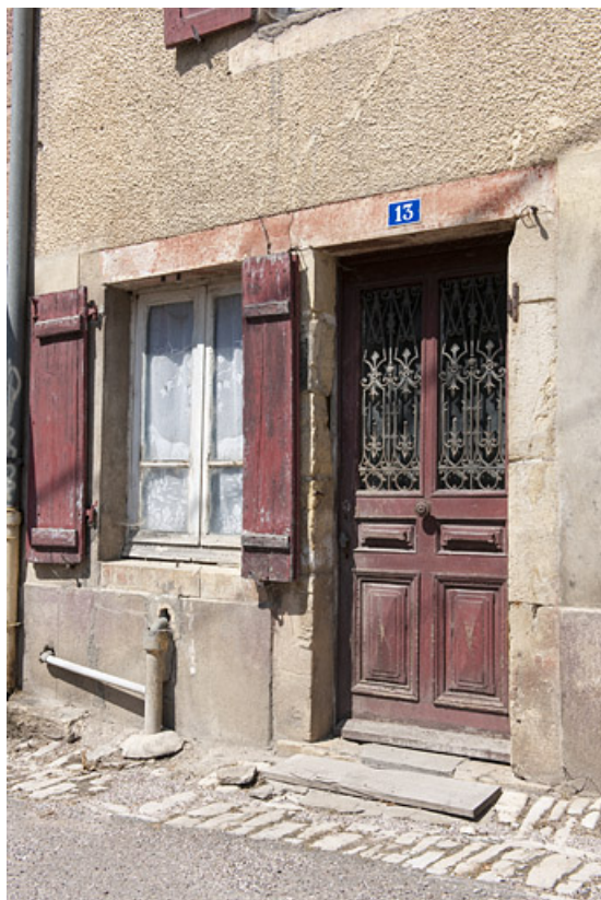
Maison de commerçant, 13 rue des Ruaux : exemple de revêtement à l'imitation du grès sur l'encadrement en pierre de taille de la porte d'entrée.
