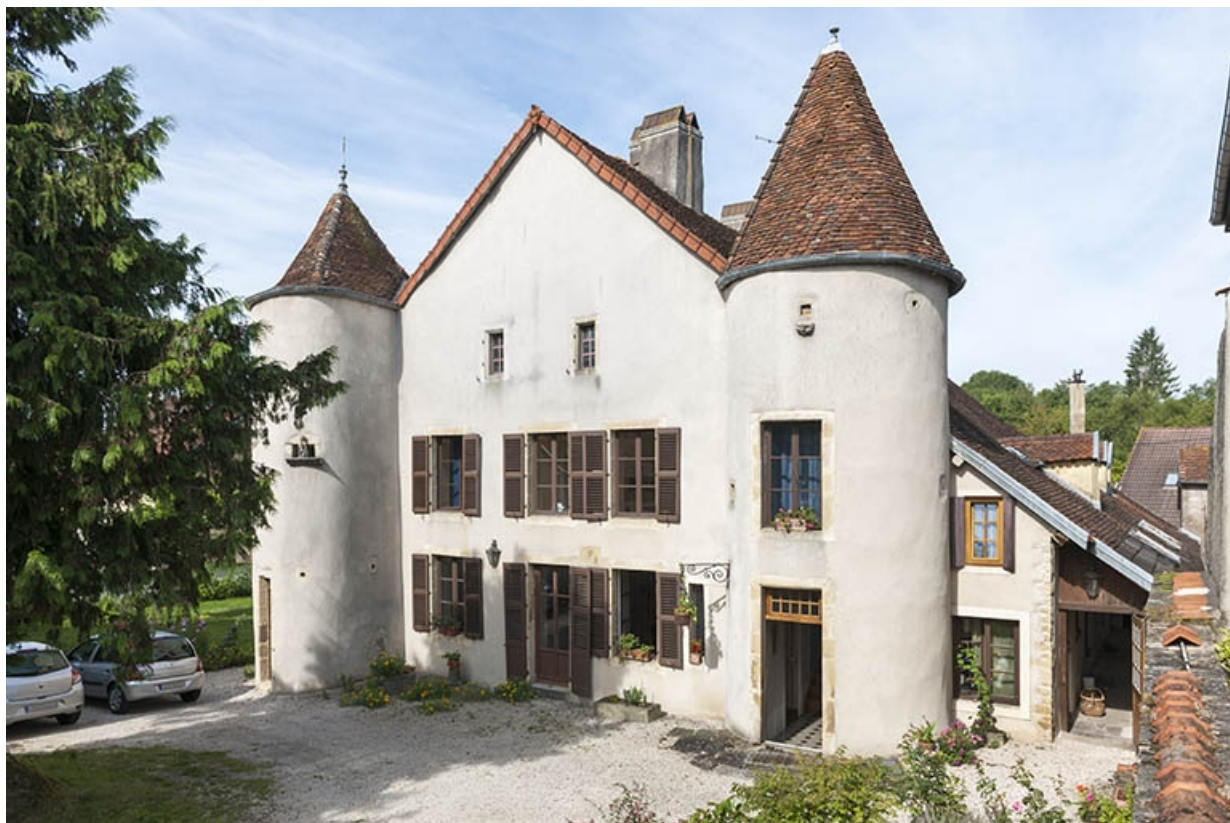
Maison dite des Ducs de Bourgogne, 39 Grande Rue. 70, Faverney
