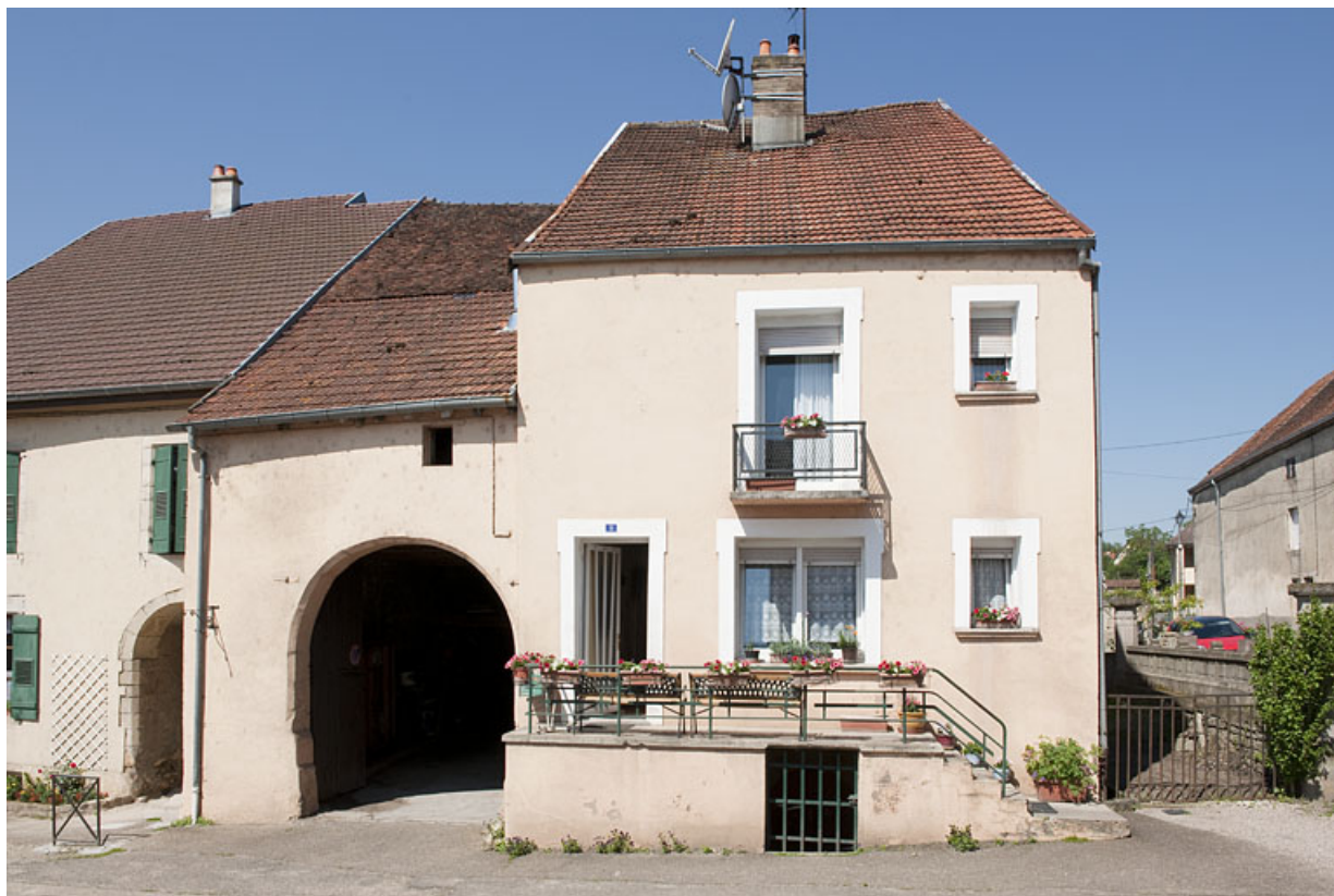
Maison, 9 Grande Rue : exemple de maison à rez-de-chaussée surélevé sur cave. 70, Favorney
