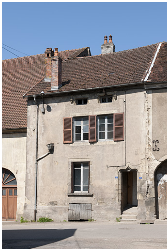
Maison, 25 et 24 Grande Rue : maison en rez-de-chaussée surélevé sur cave, avec un étage carré et un étage de comble. 70, Faverney
