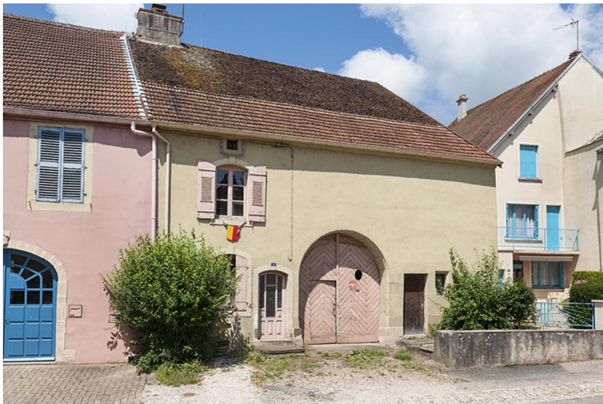
Ferme, 5 rue Bossuet : ferme à trois travées, avec habitation sur cave à un étage carré, grange et écurie (étable à vaches). 70, Faverney
