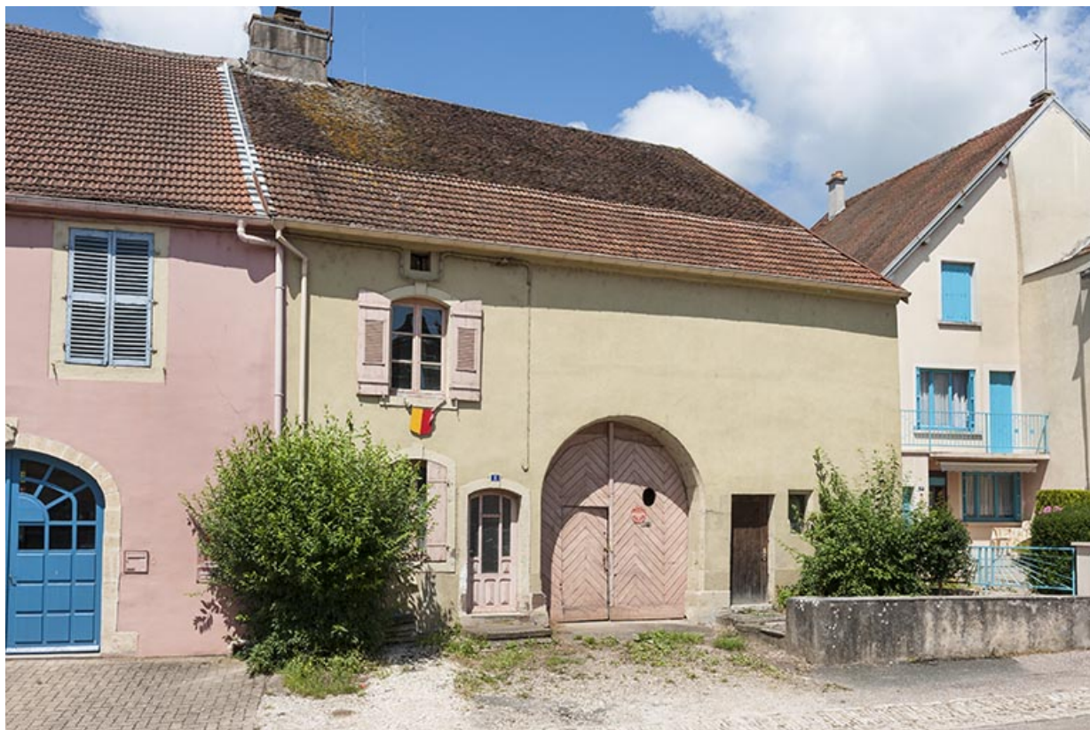
Ferme, 5 rue Bossuet : ferme à trois travées, avec habitation sur cave à un étage carré, grange et écurie (étable à vaches). 70, Faverney
