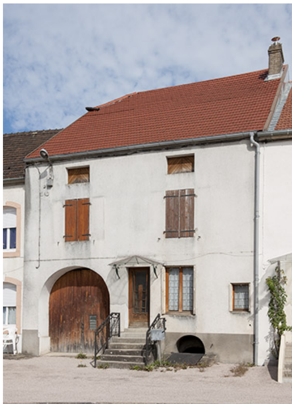
Ferme, 3 rue Arago : ferme à deux travées. 70, Faverney
