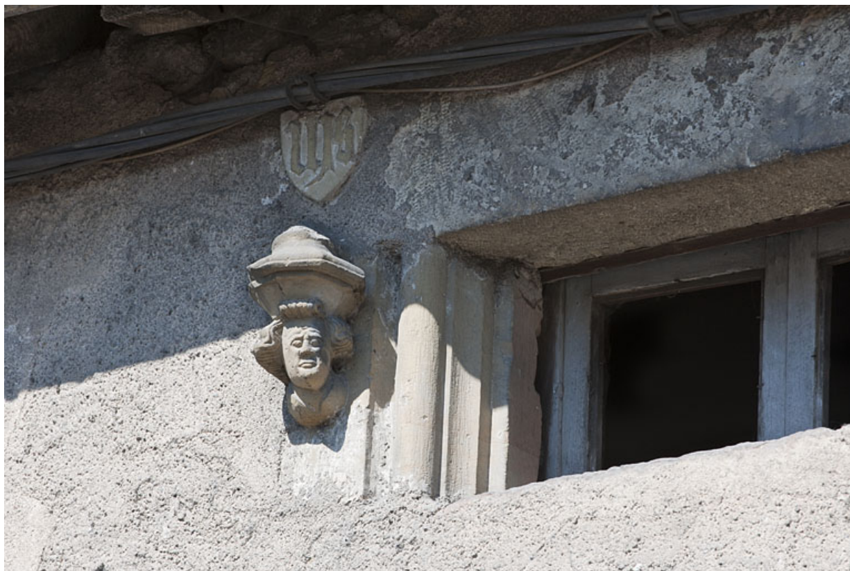
Maison, 25 et 27 Grande Rue, détail : baie à l'étage de comble cantonnée de têtes sculptées, sans doute en réemploi (tête de gauche).
