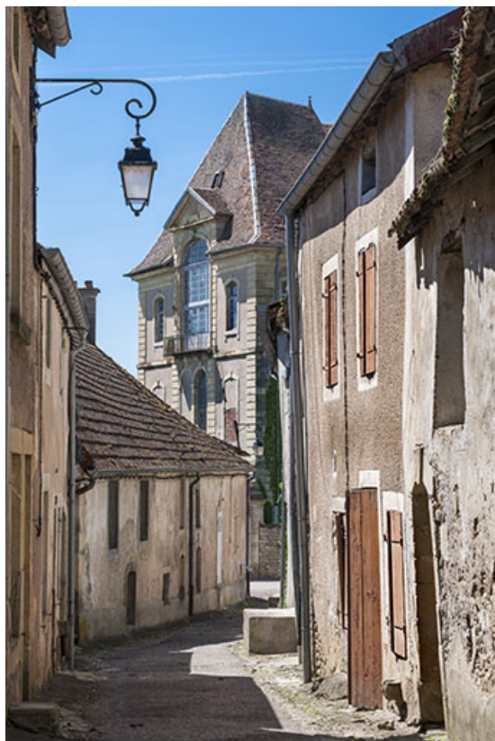
Maisons, rue d'Enfer (en direction de la rue de l'Official). 25, Jougne
