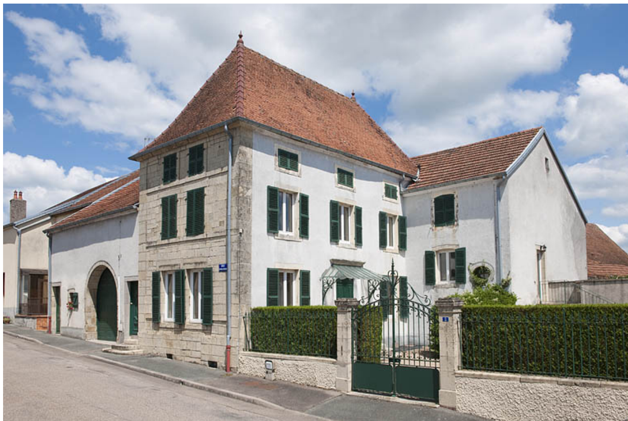
Maison, 2 rue du Général Rebillot : exemple de maison au volume imposant, construite au nord de la cité et attenante à une ferme. 70, Faverney
