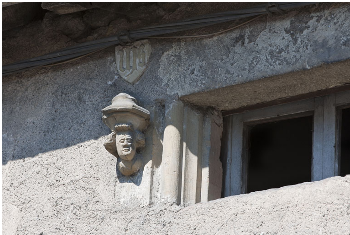
Maison, 25 et 27 Grande Rue, détail : baie à l'étage de comble cantonnée de têtes sculptées, sans doute en réemploi (tête de gauche).
