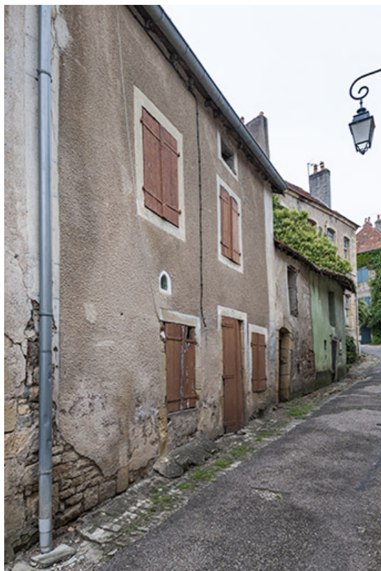
Maison, rue d'Enfer : exemple de maison à un étage carré et un étage de comble éclairé par une baie oblongue. 70, Faverney
