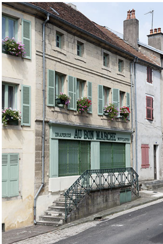
Maison, rue Thiers : maison (bâtie en 1820) à l'enseigne "Au Bon Marché", souvenir de l'activité commerciale au centre du bourg. 70, Favorney
