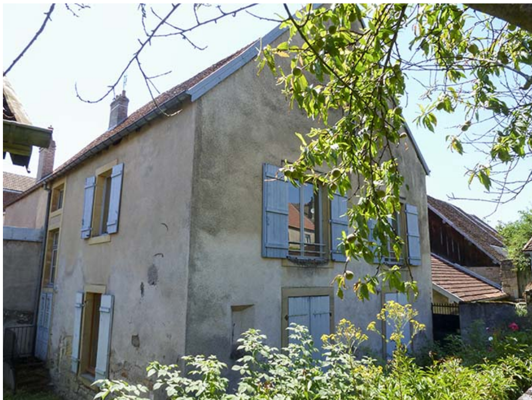
Façades postérieure et latérale droite.
