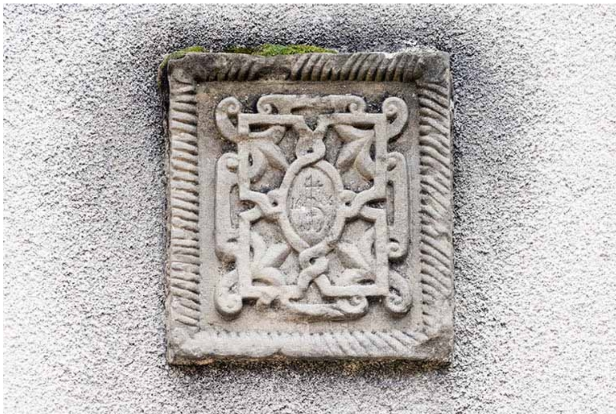
Détail de la façade antérieure : marque de marchand (4 de chiffre) portant la date 1606. 70, Faverney, 9, 11 place de la Mairie
