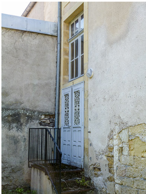
Façade latérale droite : porte de service.
