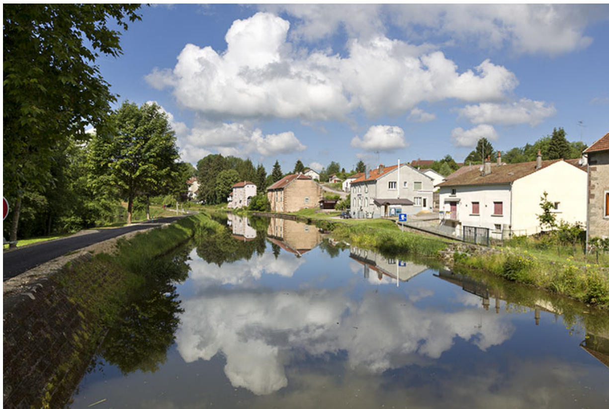
Vue depuis le pont tournant sur les habitations situées rue de la Tuilerie. 70, Selles
