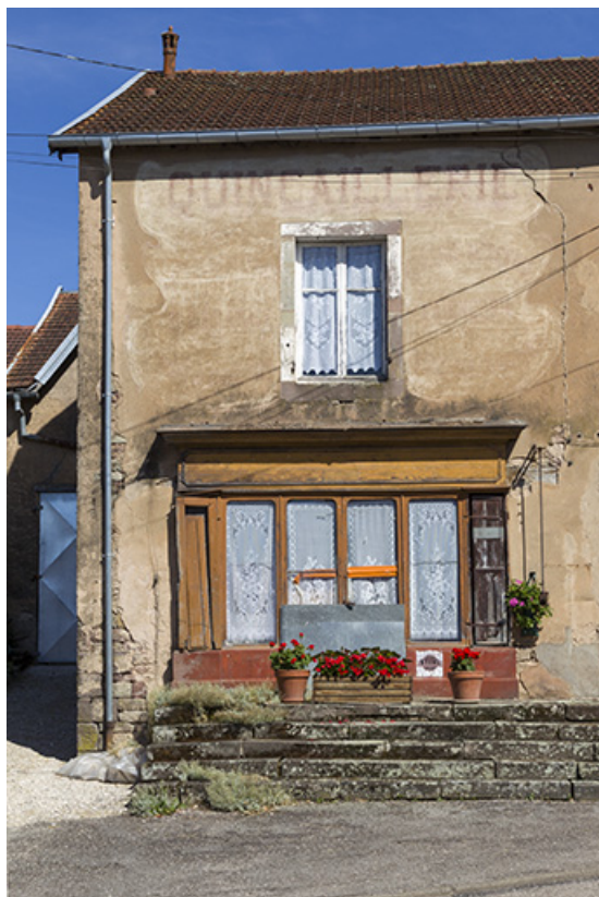
Ancienne boutique, rue de la Forge. 70, Selles
